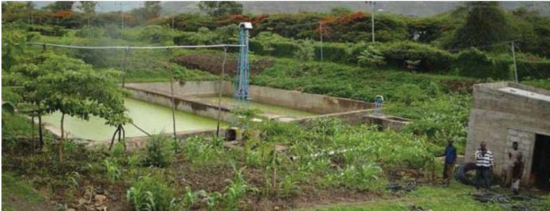
Vista general y caseta de la bomba
