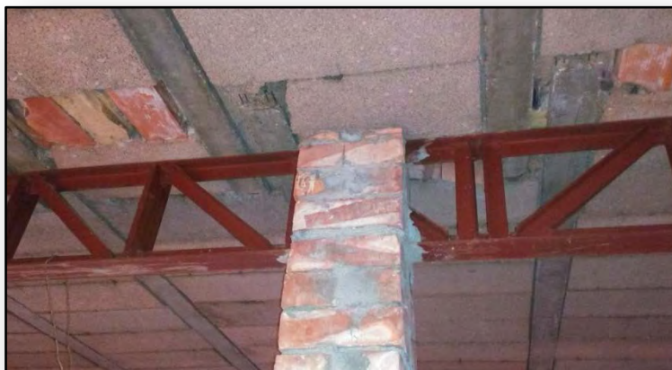
Imagen 8: Encuentro del pilar con la viga existente.
