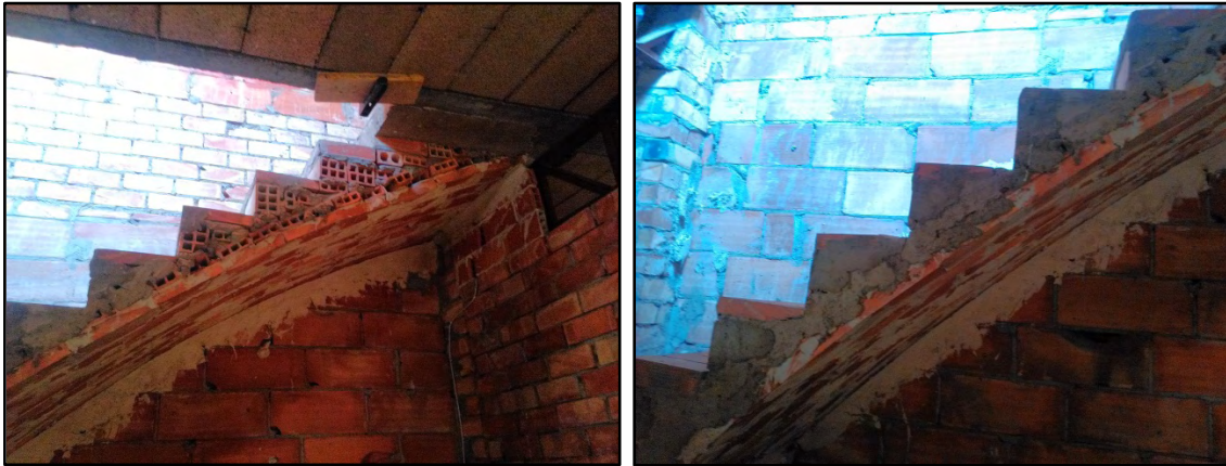
Imagen 13: Fotografías escalera actual.
