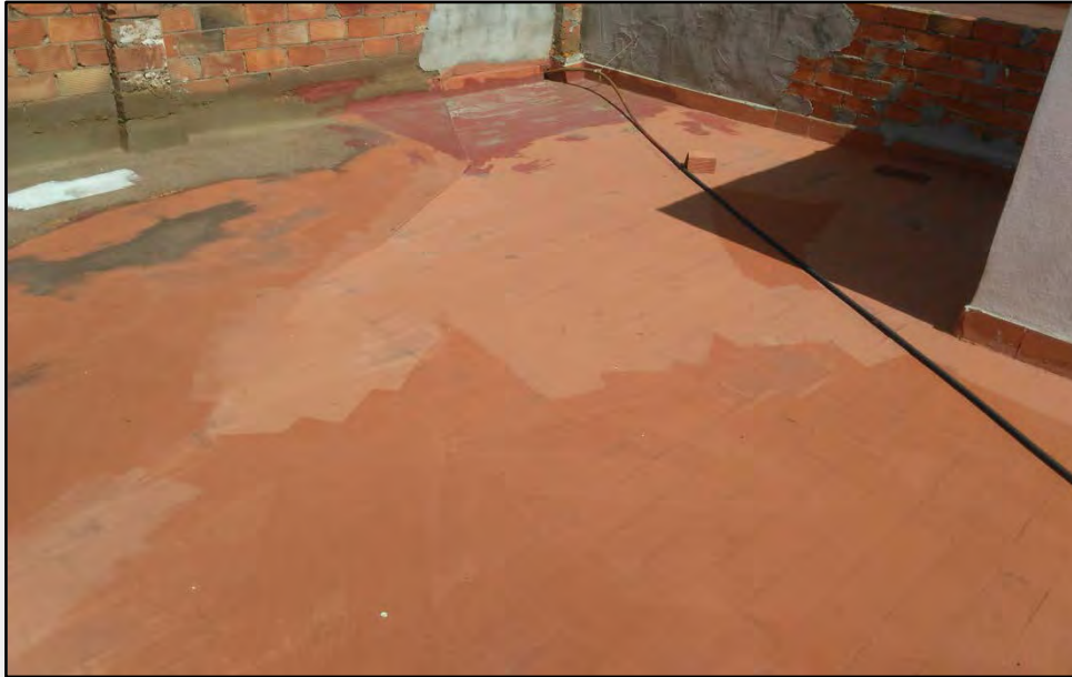
Imagen 12: Fotografía cubierta actual.
