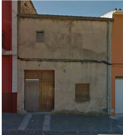
Imagen 66: Fachada principal de una vivienda unifamiliar
