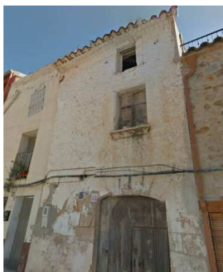
Imágenes 91: Carpintería exterior
