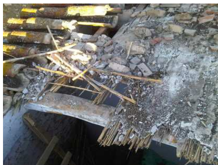
Imagen 68: Cubierta inclinada de viguetas de madera, cañizo, mortero y teja árabe
