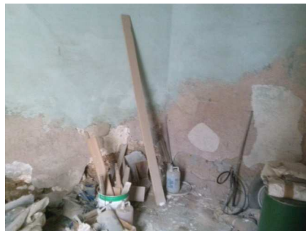
Imagen 89: Guarnecido ubicado en sala de estar
