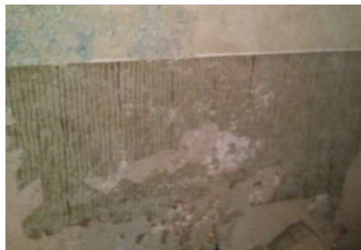
Imagen 88: Papel pintado ubicado en paramento interior
