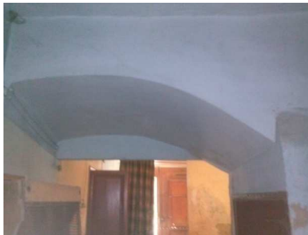
Imagen 72: Hueco de escalera abovedada
