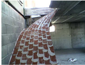
Imagen 71: Correa de escalera abovedada
