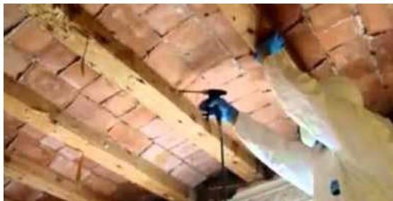
Imagen 102: Aplicación en una vigueta del tratamiento químico
