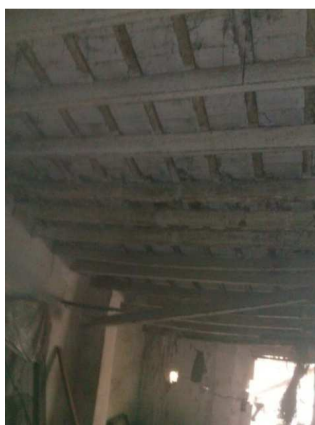
Imagen 69: Cubierta inclinada del granero
