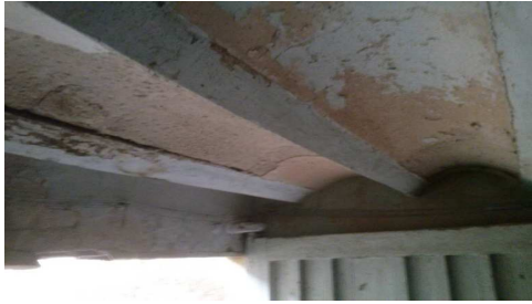
Imagen 59 y 60: Viguetas dañadas por deslignificación y por termitas
