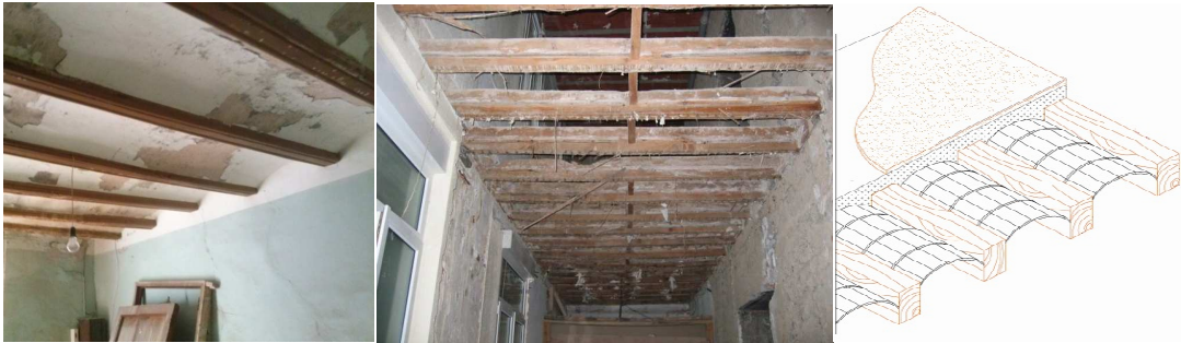
Imagen 56, 57 y 58: Forjado tradicional de la vivienda
