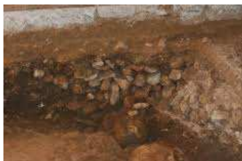
Imagen 55: Cimentación de muro de piedra
