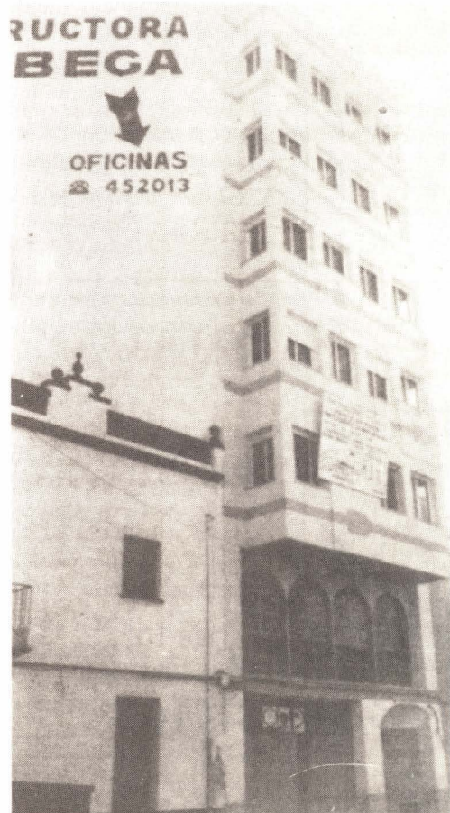
EDIFICIO «PUENTE». Vinaròs
