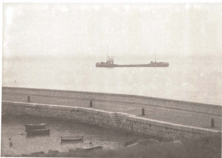
Se están efectuando importantes obras de dragado de nuestro puerto. Foto: Reula
