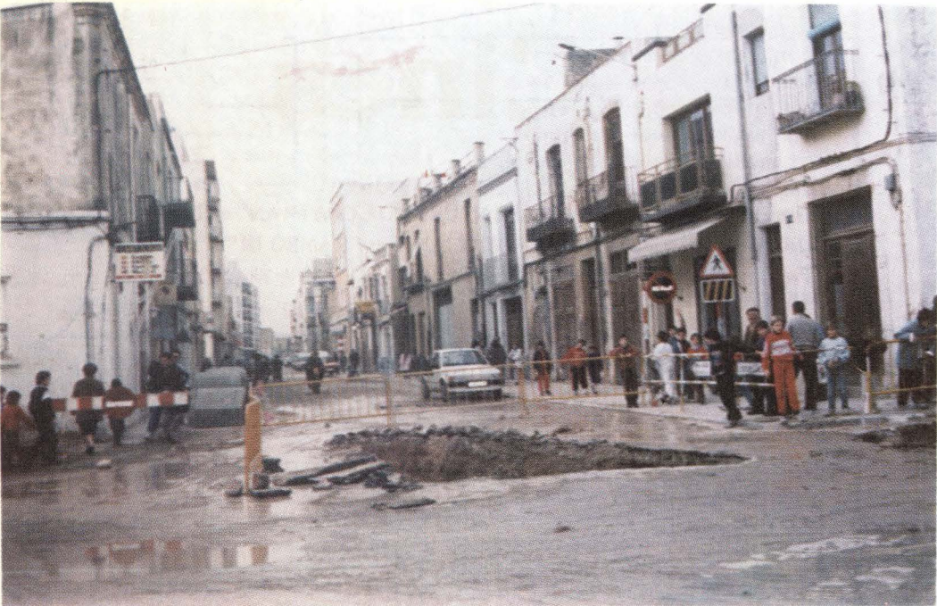
Después del paréntesis festivo de Navidad y Reyes, se han reiniciado las obras del alcantarillado de la calle Pilar-Avda. Libertad
