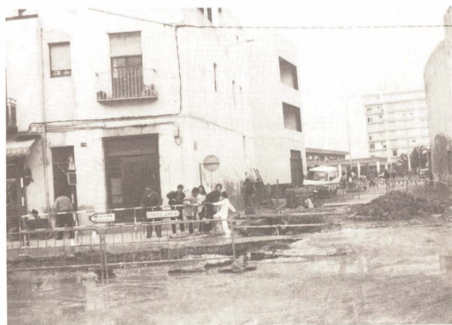
Alcantarillado c/. Pilar, Avda. Libertad. Se ha reemprendido la actividad de obras públicas después del paréntesis de las fiestas navideñas y reyes. Foto: Reula
