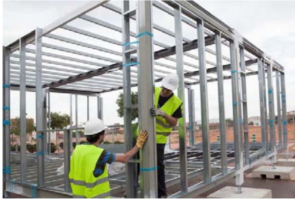
Ilustración 55 Montaje de estructura mixta con acero laminado en caliente y steel-frame utilizada en el prototipo éBRICKhouse; Fuente: Fotos del equipo
