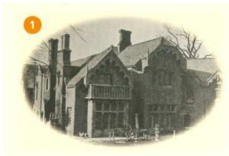
Ilustración 1 Casa de hormigón para John White, Swanscombe, Kent, 1835; Fuente: Concrete through the ages (British cement association)
