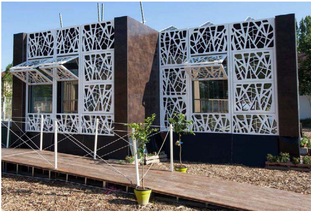
Ilustración 31 Acabado de la fachada sur; Fuente: eBRICKhouse project manual
