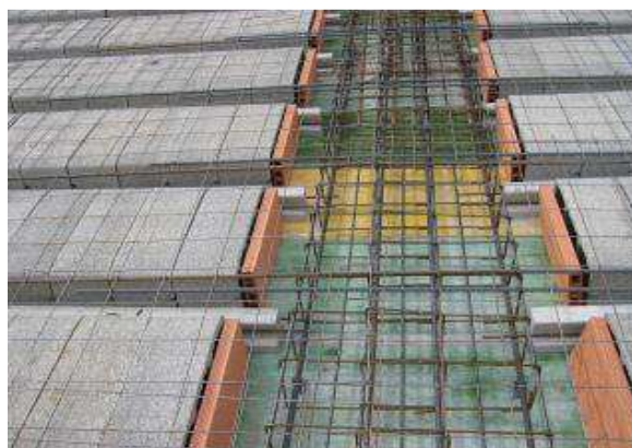
Ilustración 44 Bloqueo de los huecos de bovedilla previo al hormigonado; Fuente: http://www.enriquealario.com/ejecucion-de-forjados-unidireccionales/
