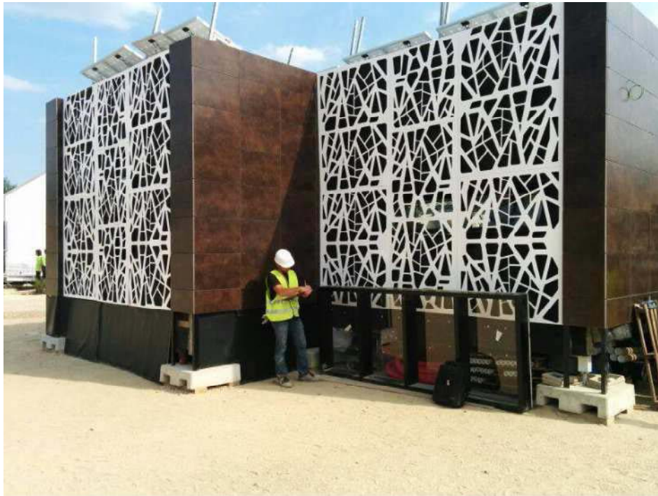
Ilustración 30 Acabado de las protecciones solares en fachada norte; Fuente: eBRICKhouse project manual
