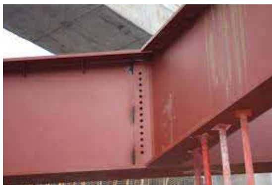
Ilustración 47 Apoyo provisional con puntales de viga metálica; Fuente: epachon.wordpress.com
