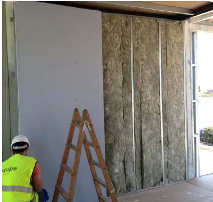
Ilustración 22 Montaje de la cara interior de la pared; Fuente: eBRICKhouse project manual
