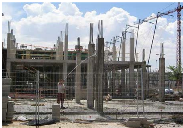
Ilustración 45 Curado del hormigón de pilare; Fuente: http://www.enriquealario.com/ejecucion-de-forjados-unidireccionales/
