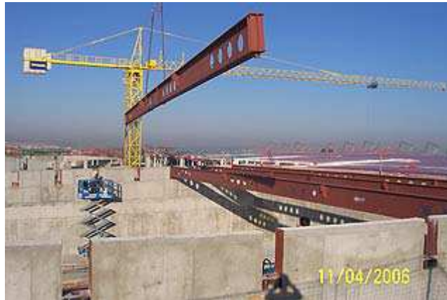
Ilustración 65 Correcto transporte de viga metálica mediante grúa; Fuente: parqueciencias.com
