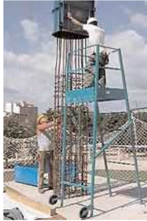
Ilustración 59 – Trabajo desde plataforma de hormigonado; Fuente: Construmatica
