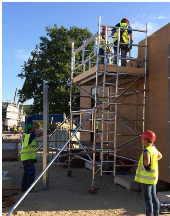
Ilustración 56 Montaje de revestimiento de OSB sobre Steel-Frame; Fuente: fotos del equipo
