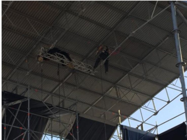
Ilustración 14. Colocación puntos de rigging MBC 2015. Fuente: Propia
