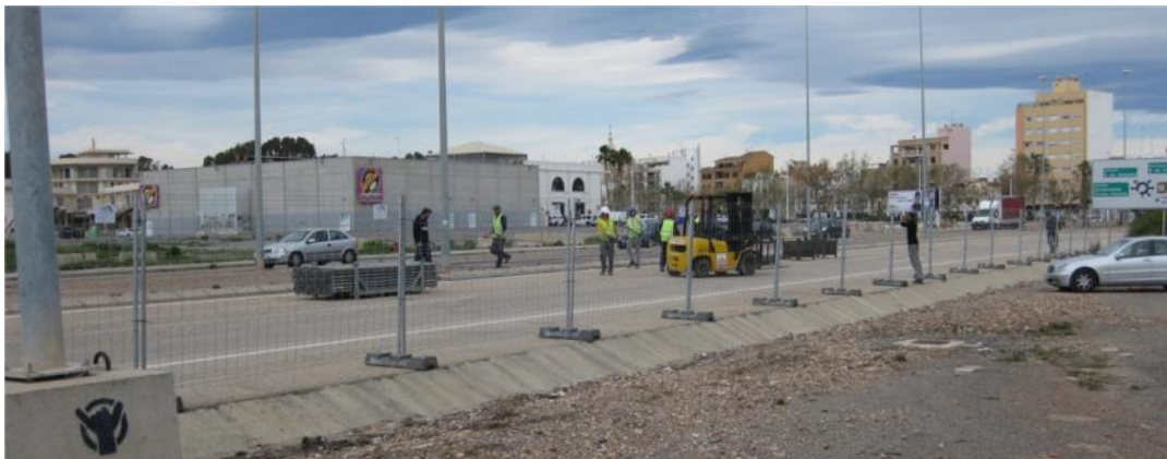
Ilustración 8. Montaje vallado perimetral MBC 2015. Fuente: Propia
