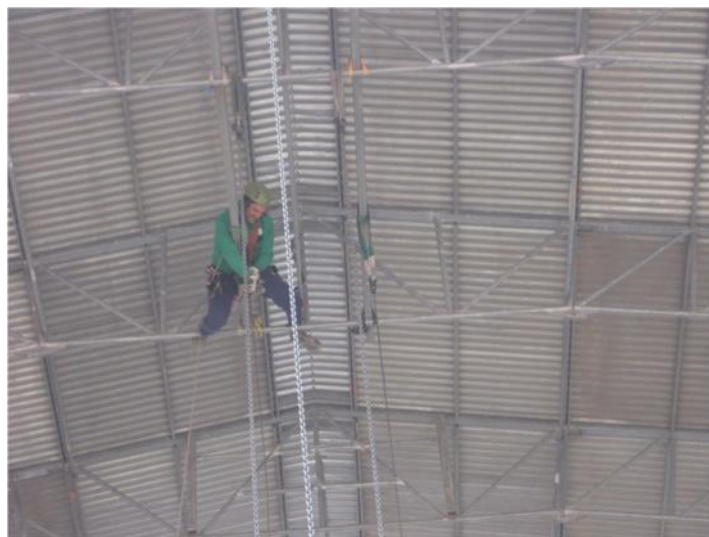
Ilustración 16. Desmontaje puntos de rigging MBC 2015. Fuente: Propia
