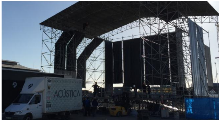
Ilustración 15. Desmontaje luz y sonido MBC 2015. Fuente: Propia
