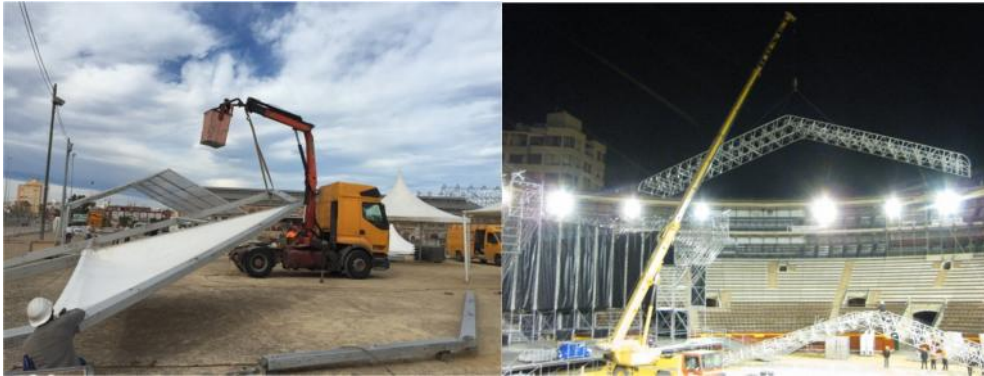
Ilustración 11. Elevación pórtico carpa MBC 2015. Fuente: Propia
