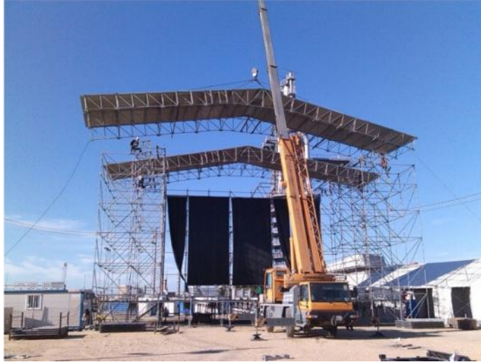
Ilustración 18. Desmontaje cubierta escenario MBC 2015. Fuente: Propia
