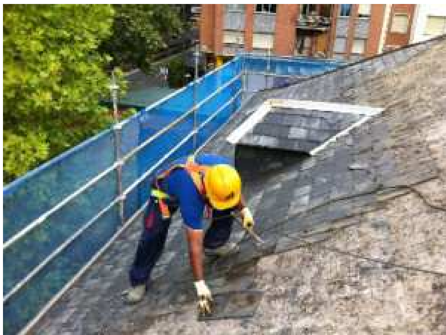
Ilustración 3: Correcta utilización de EPI's y de valla de seguridad.
