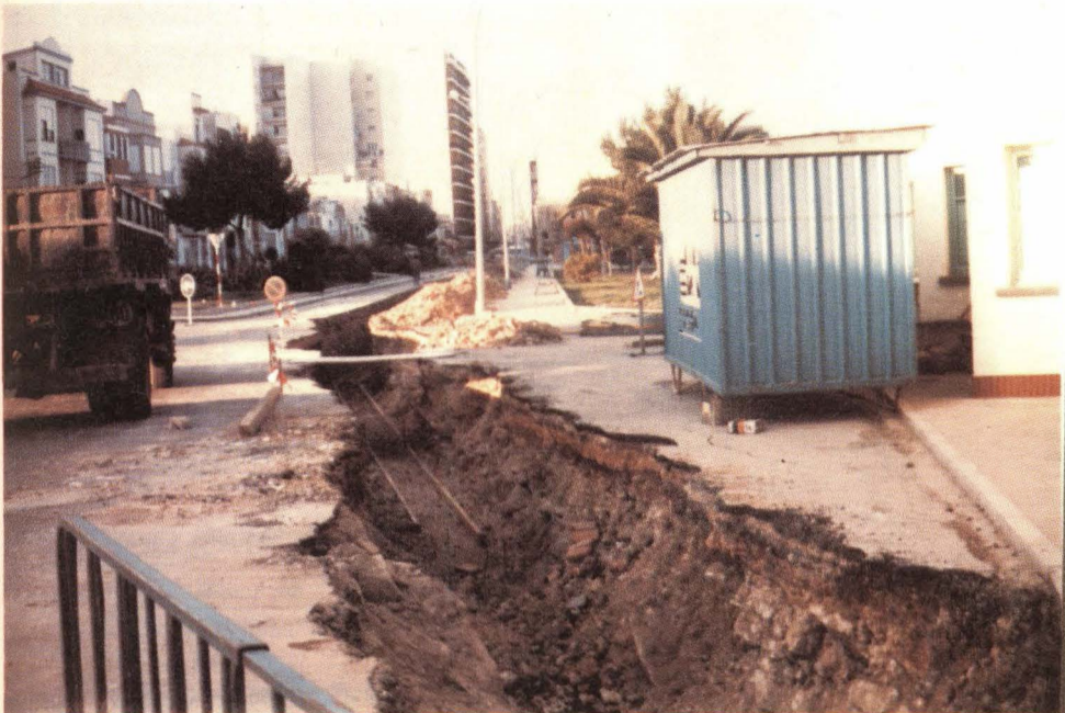
Han empezado las obras del colector para el alcantarillado. Foto: Reula
