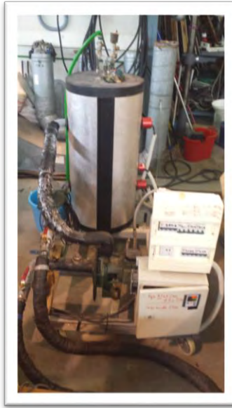
Ilustración 31. S.A.T en el lado de baja temperatura (evaporador).
