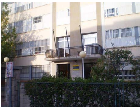
Figura 2.1. Façana principal de l'IES Penyagolosa
