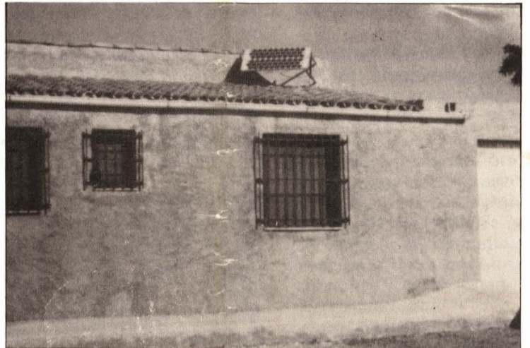
INSTALACION DE DOS PANELES EN UN CHALET
