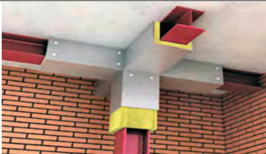
Figura 5: Protección mediante lana de roca
