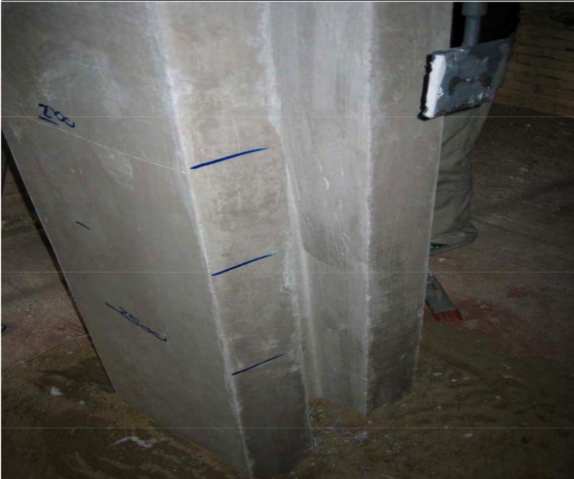
Figura 7: Protección mediante placas de yeso
