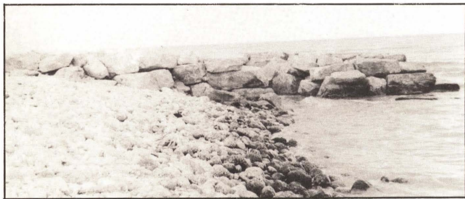
...actualmente las aguas se vierten sin ser depuradas
