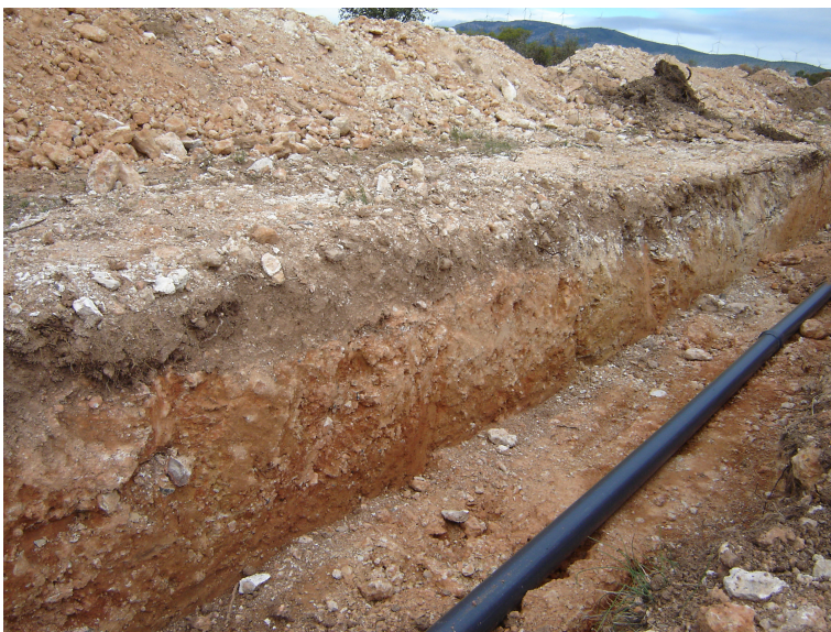
Foto 3: Apertura de zanjas (fuente propia).
