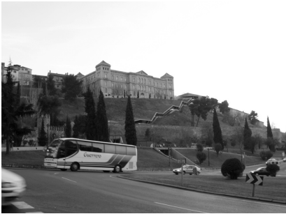
Ávila, terraplè de la muralla habilitat per a la visita pública.
