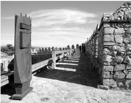
Àvila, terraplè de la muralla habilitat per a la visita pública.
