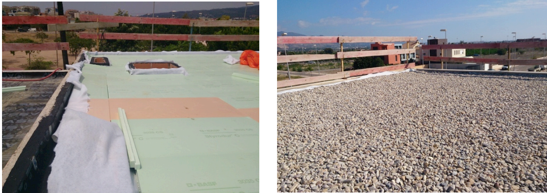
Fig. 31: Cubiertas durante su ejecución (izquierda) y finalizadas (derecha)
