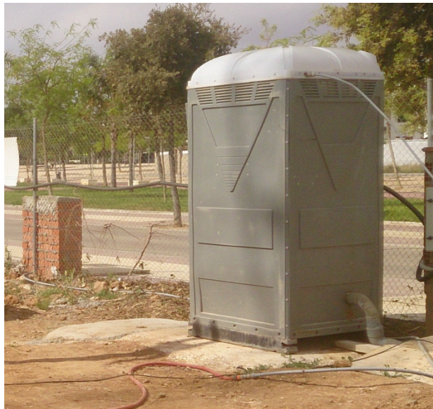
Fig. 61: Aseo provisional de obra
