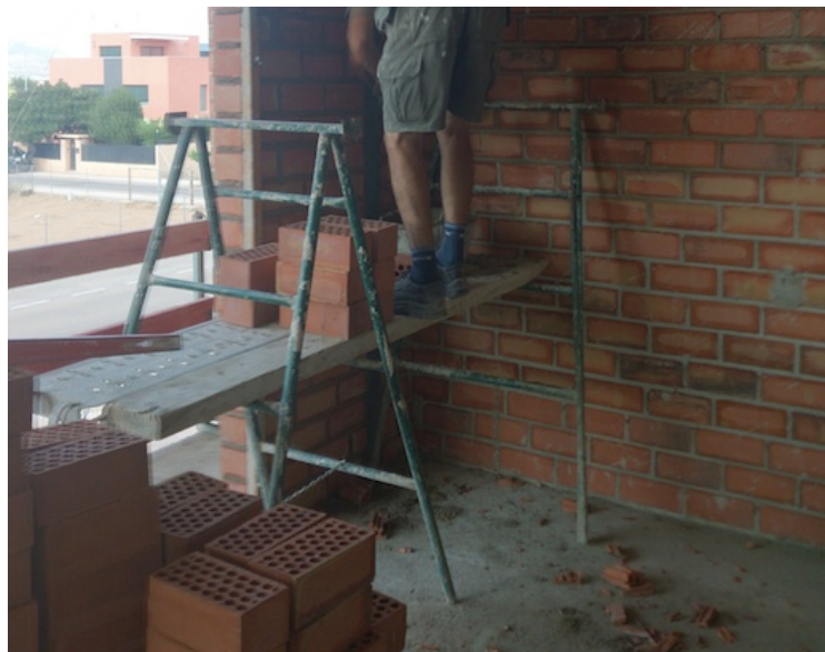
Fig. 46: Operario realizando sus trabajos sobre un caballete incompleto
