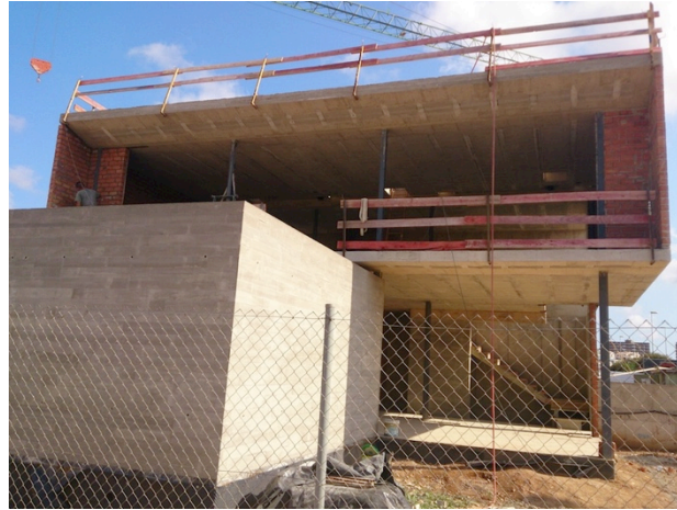
Fig. 64: Barandilla perimetral en bordes de forjado
