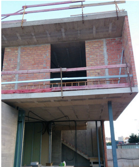
Fig. 52: Sistemas de vallado en bordes de forjado
