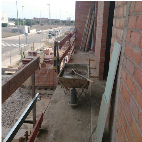
Fig. 53: Carretilla de obra para el vertido de mortero autonivelante
