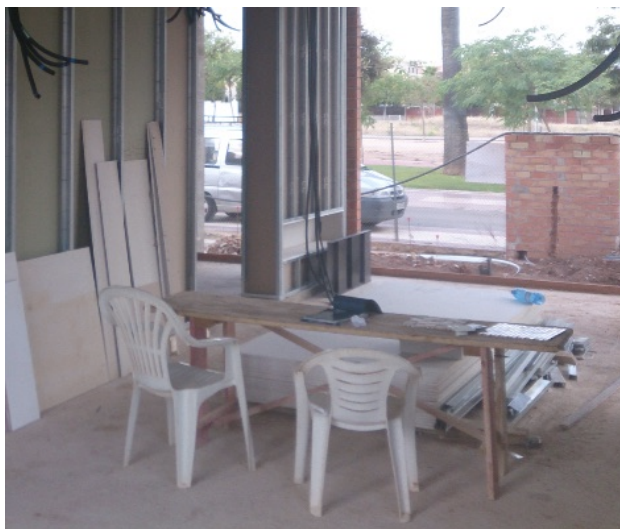
Fig. 62: Despacho de obra provisional en el interior del edificio
