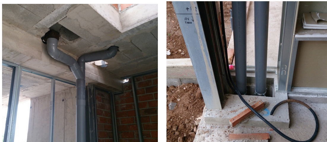
Fig. 35: Bajantes pluviales de la vivienda
