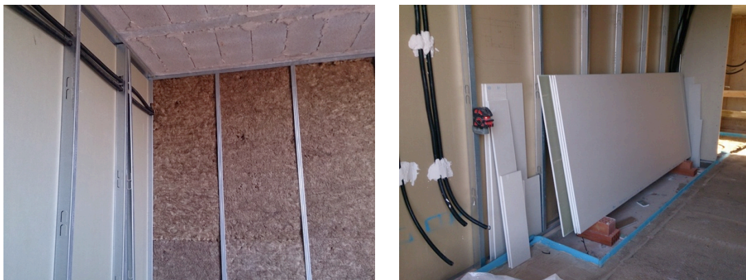
Fig. 32: Compartimentación interior a base de paneles de “cartón – Yeso”
