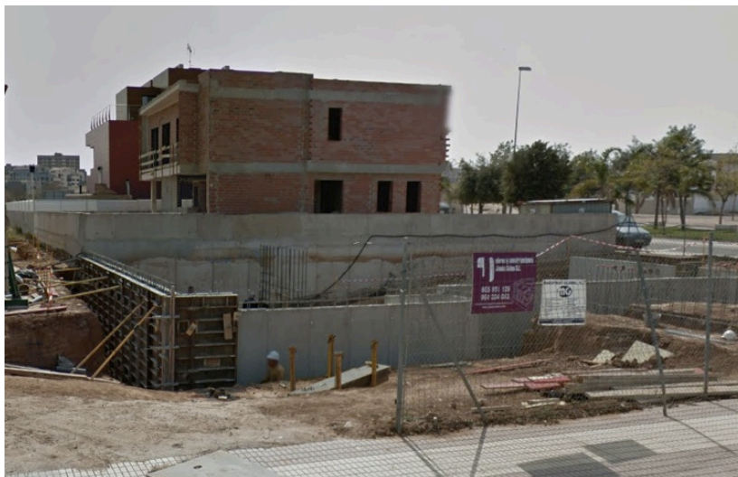
Fig. 17: Construcción del muro de sótano
