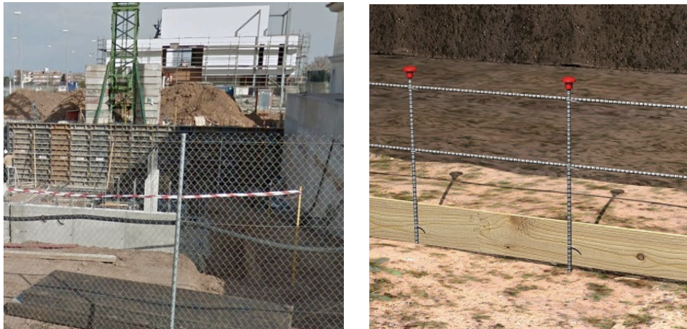
Fig. 53: Valla do perimetral de bordes de excavación
