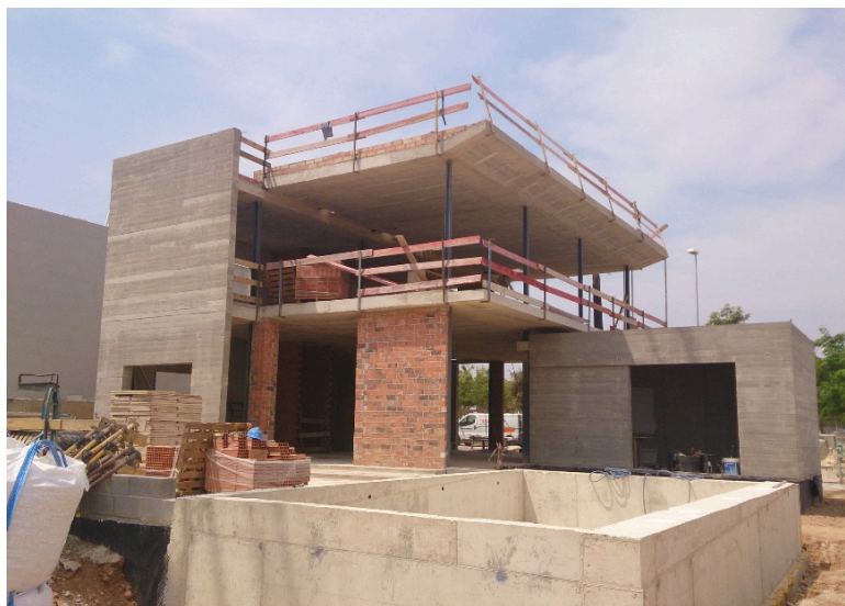
Fig. 22: Perspectiva de la estructura finalizada
