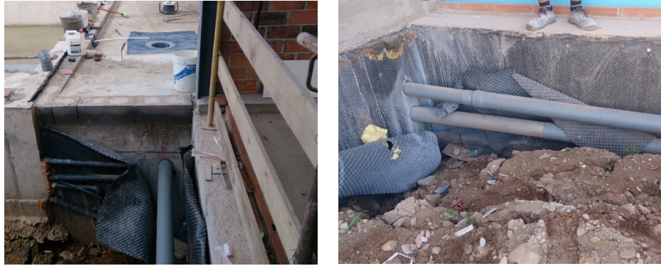
Fig. 57: Disposición de los colectores enterrados y desplazados
