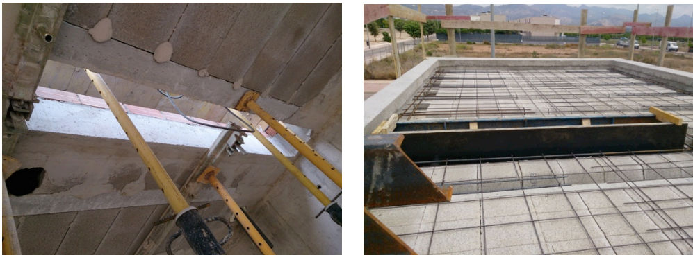
Fig. 41: Ejecución de la claraboya del cuarto de bajo H. Invitados
