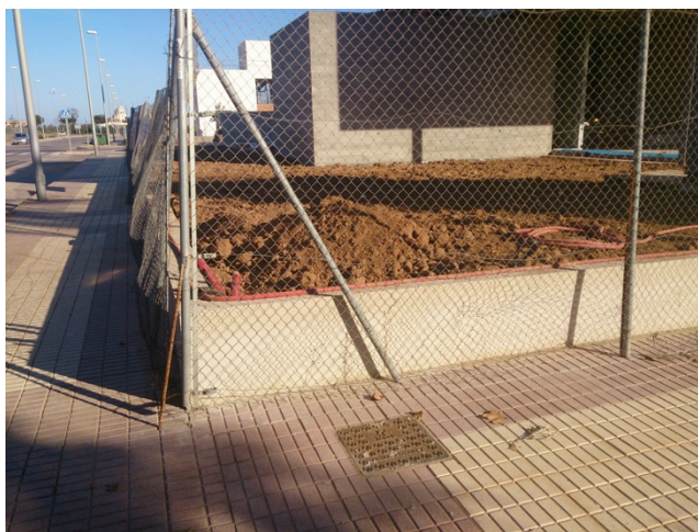
Fig. 59: Vallado perimetral de la parcela
