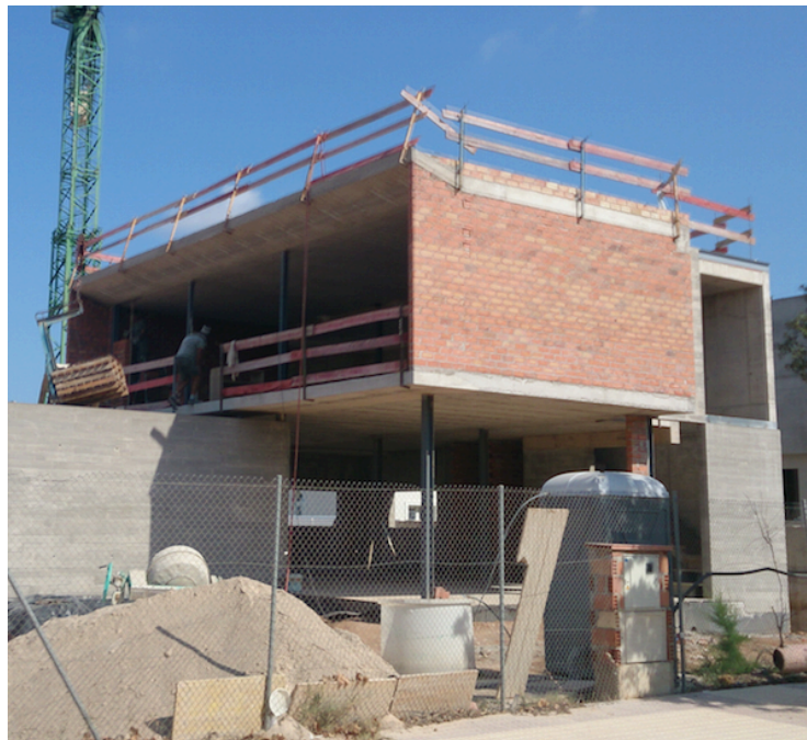
Fig.: Soporte de fachada oeste 1ª planta (ladrillo perforado de 1/2 pie)
