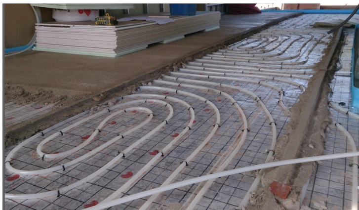
Fig. 54: Maestreado del mortero autonivelante de Suelo radiante
