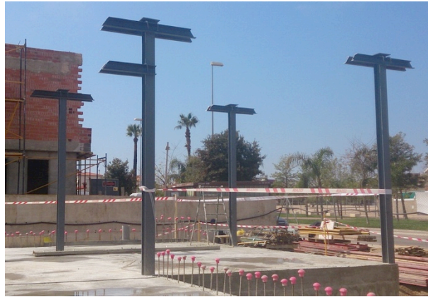
Fig. 23: Pilares metálicos en obra
