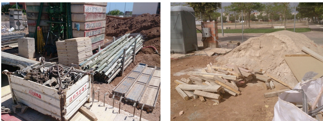
Fig. 63: Acopios de materiales ordenados y desordenados
