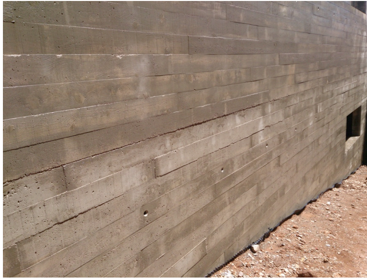
Fig. 18: Muro de hormigón rampa de sótano
