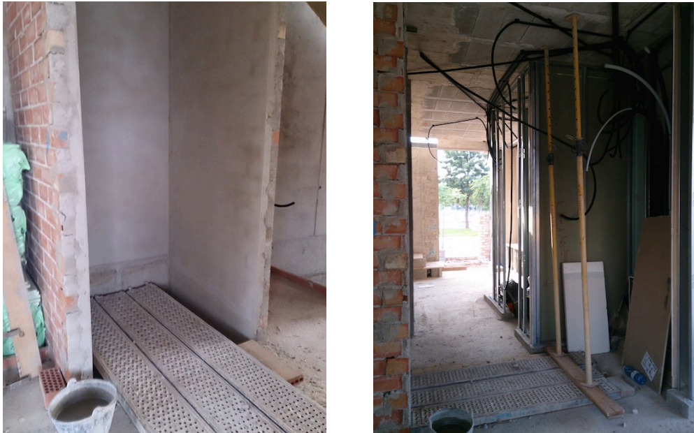
Fig. 47: Andamio utilizado para el enlucido del hueco de ascensor
