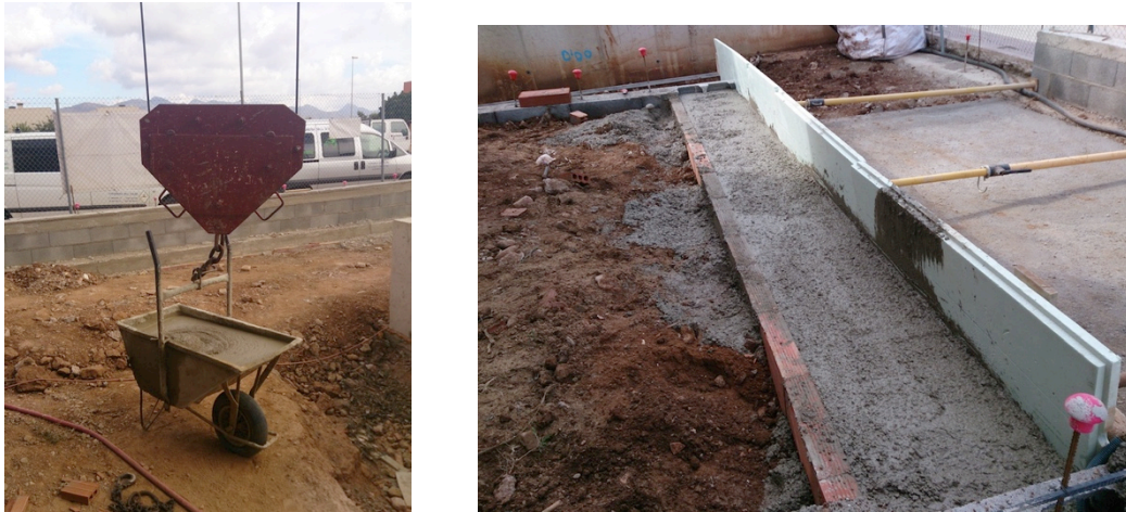
Fig. 55: Hormigonado de solera a con carretilla de obra elevada con grúa torre
