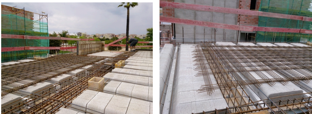
Fig. 20: Vistas del forjado tipo del edificio
