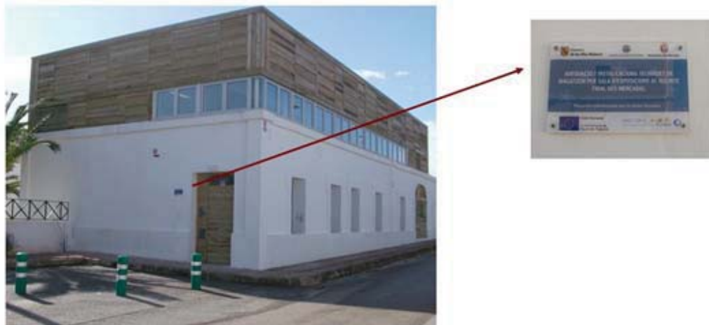
Placa de adecuación e instalaciones técnicas de almacén para sala de exposiciones en el recinto ferial de Es Mercadal
