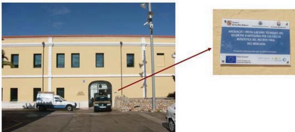
Placa de adecuación e instalaciones técnicas en el segundo piso de la artesanía para la exposición de la colección de Museo de Es Mercadal
