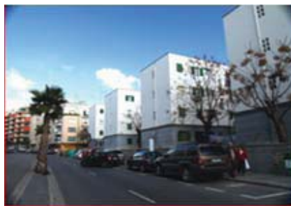
Foto de las viviendas de Corca vistas des de la C. General Riera (zona de intervenció)
