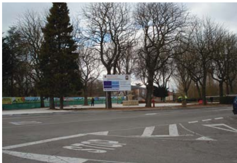
Cartel colocado durante las obras.
