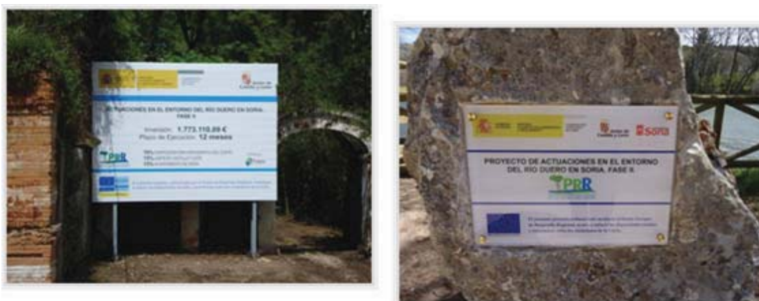
Cartel de obra y Placa Explicativa Permanente de la actuación en el entorno del río Duero en Soria.
