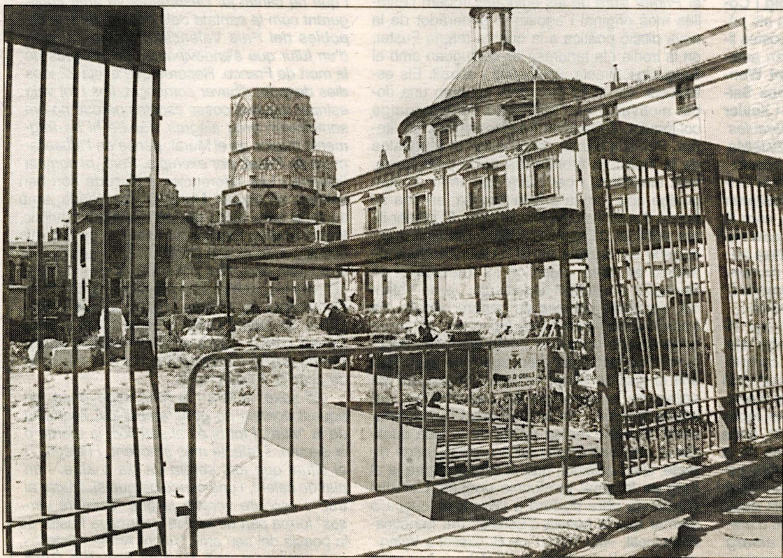
La puerta de acceso a la Almoína ha sido sustituida por una valla.
