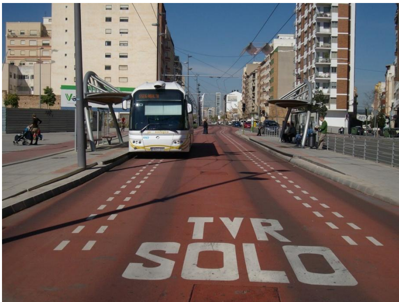
Calle utilizada únicamente por el trolebús en doble dirección Foto : J.J. Olaizola
