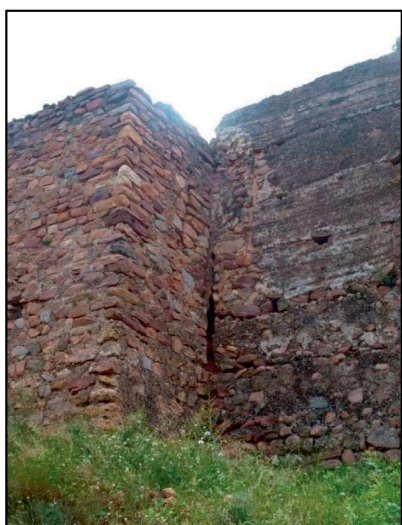
5. Vista torre y arranque lienzo W.
