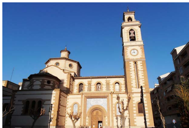
Figura 13. Iglesia de San Pedro Apóstol
