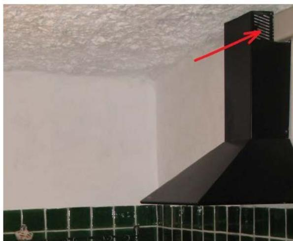
Detalle de remate exterior de la salida de humos. Campana extractora y tubo de extracción colgado.
