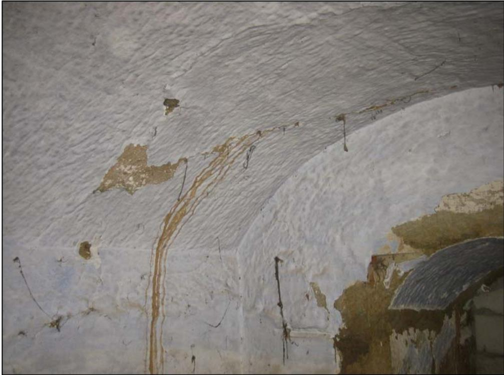
Fotografía nº 1.- Filtración de agua a través de fracturas.
