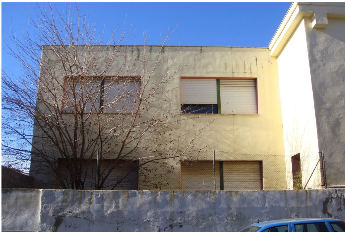
Fachada este con sur. Unión de antiguo colegio con residencia
