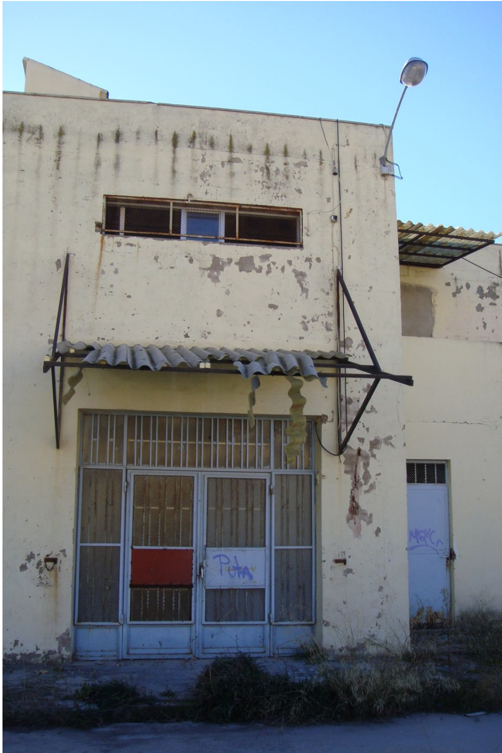
Fachada Norte. Entrada principal a antiguo colegio y futura entrada principal proyectada
