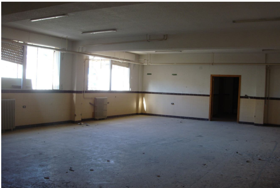
Comedor del antiguo colegio zona de ampliación
