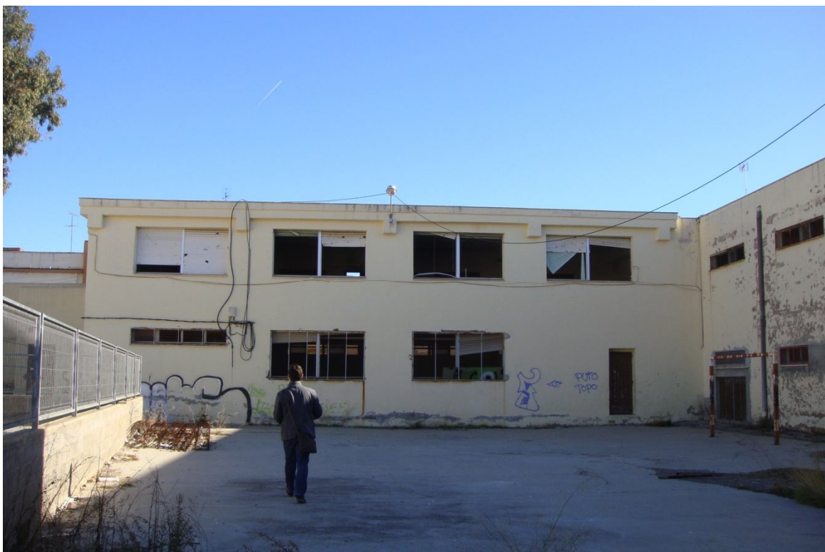
Fachada oeste. Zona ampliación a residencia.
