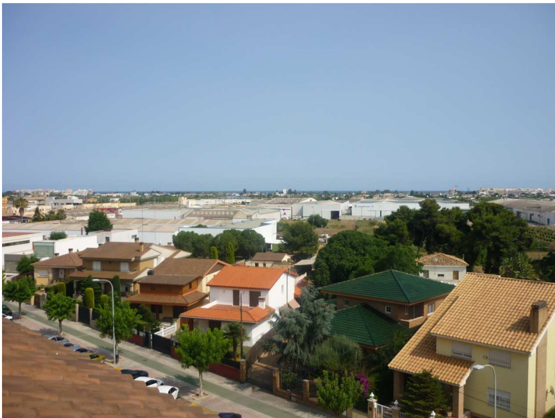
Figura 10.1.4 Viviendas situadas enfrente del edificio.
