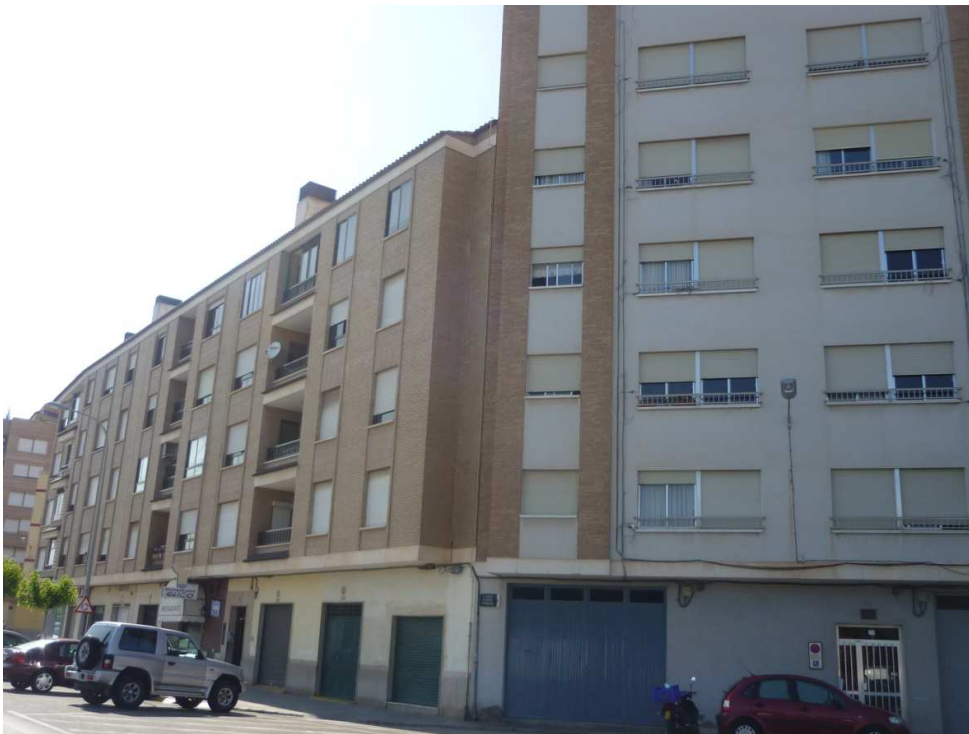
Figura 10.1.2 Edificio y los que están medianeros con él.
