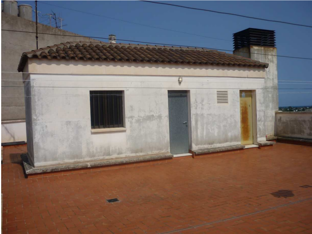
Figura 10.1.9 Casetón Cubierta, Cuarto Maquinaria Ascensor y Shunt Chimeneas.
