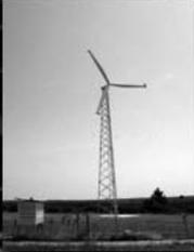
**Pequeña turbina AOC 15/50 de 50 kW para sistemas eólico-diesel, combinando su uso con volantes de inercia de alta velocidad, CEDER, Soria**
