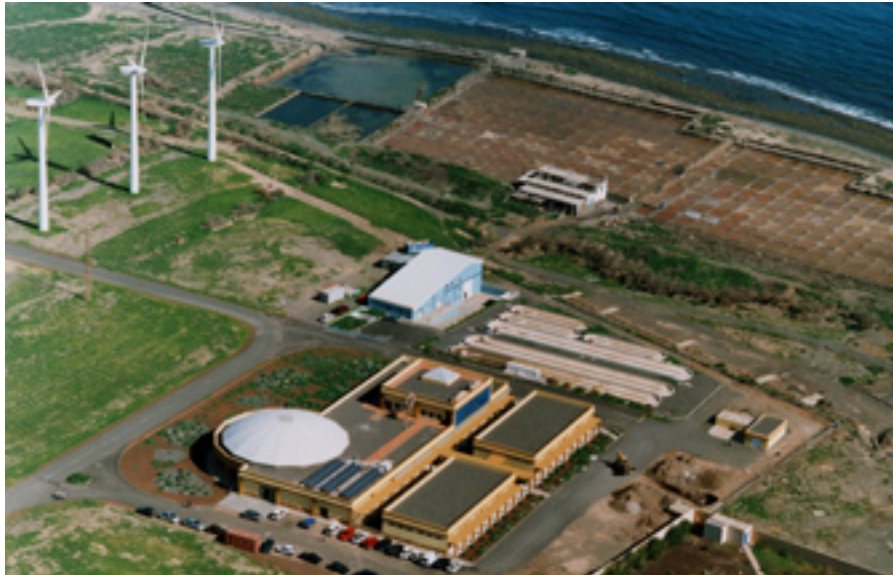
Edificio de Ingeniería, Campus de Tafira.
