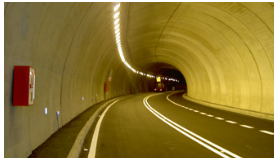
Túnel de Valverde, El Hierro.
