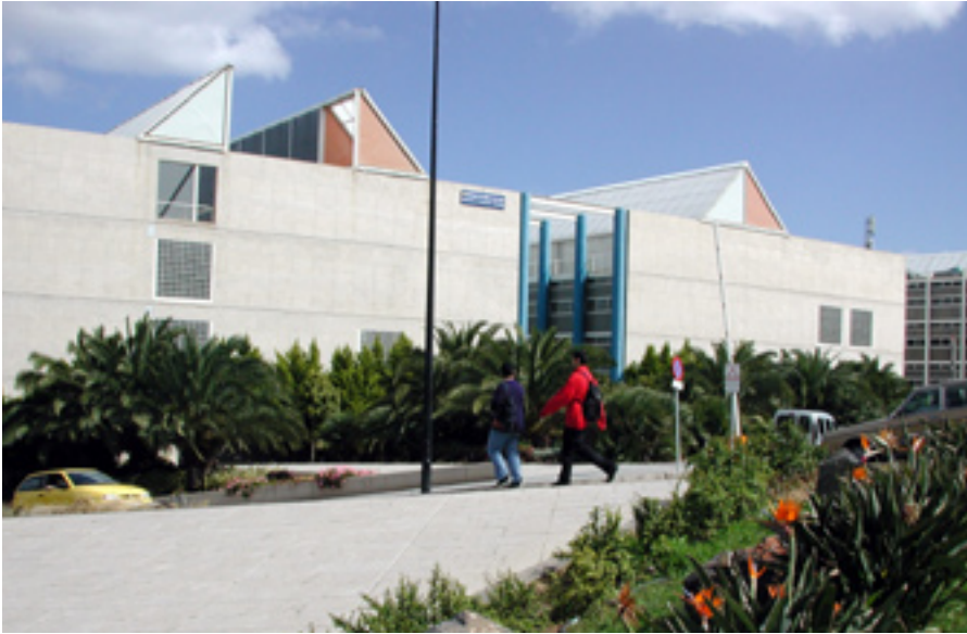
Edificio de Ciencias Básicas, ULPGC.
