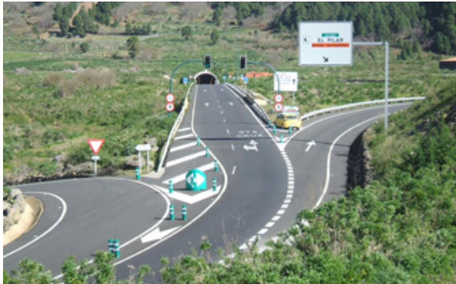
Túnel La Cumbre de La Cumbre, La Palma.
