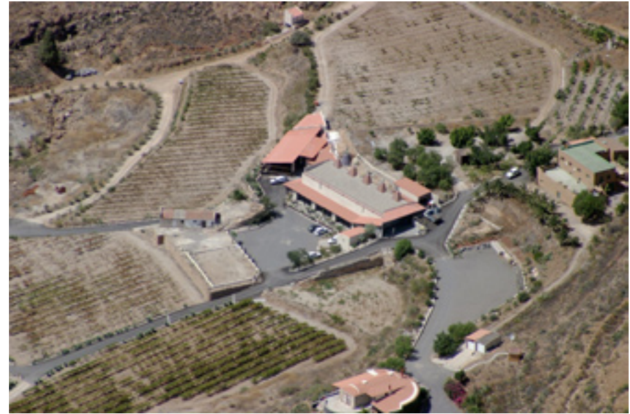
Vista aérea de las instalaciones de Frontos.
