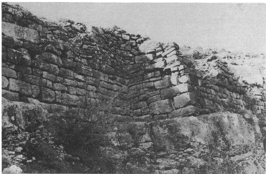
Làmina VIII.— 1) Vista general del tram de la muralla existent al Nord de l'entrada; 2) Detall del colze que forma la muralla en el mateix tram.
