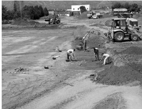
Figura 4.– Desarrollo de los trabajos de excavación en extensión en Costamar: excavación mecánica de la capa superficial y trabajos de limpieza y delimitación manual de las estructuras.
