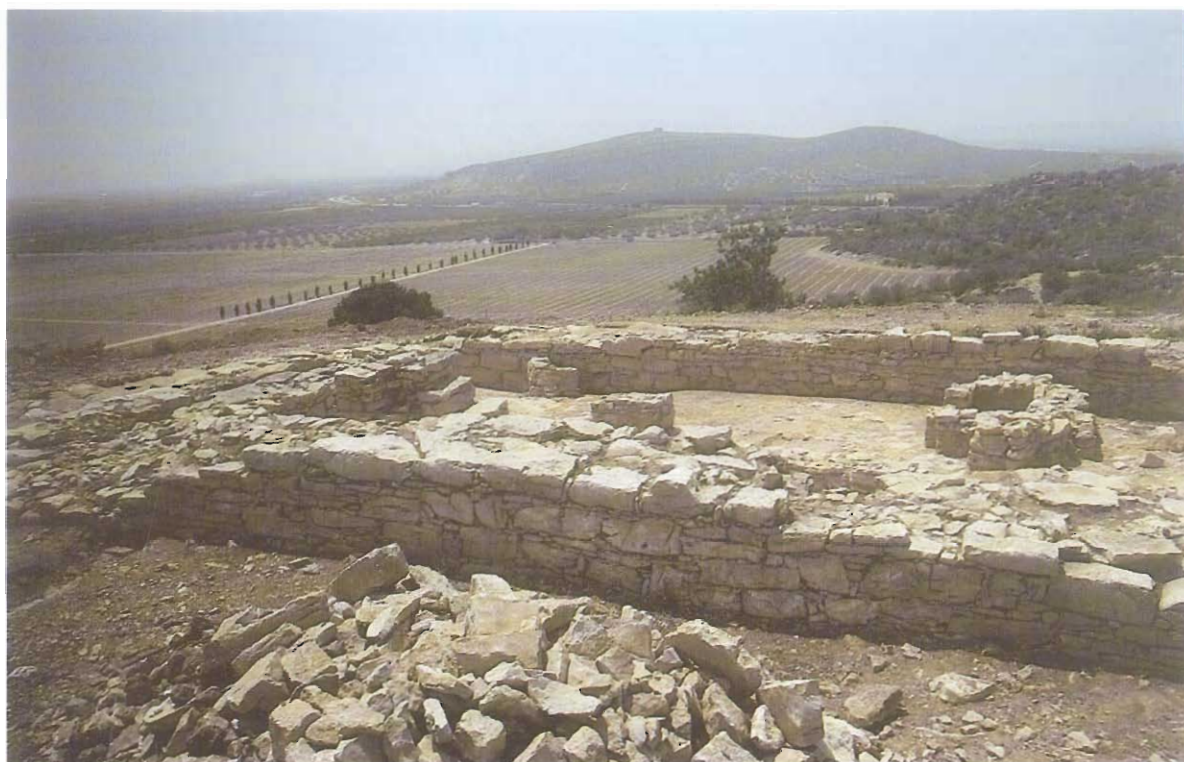
1. Vista general del edificio desde el norte.
