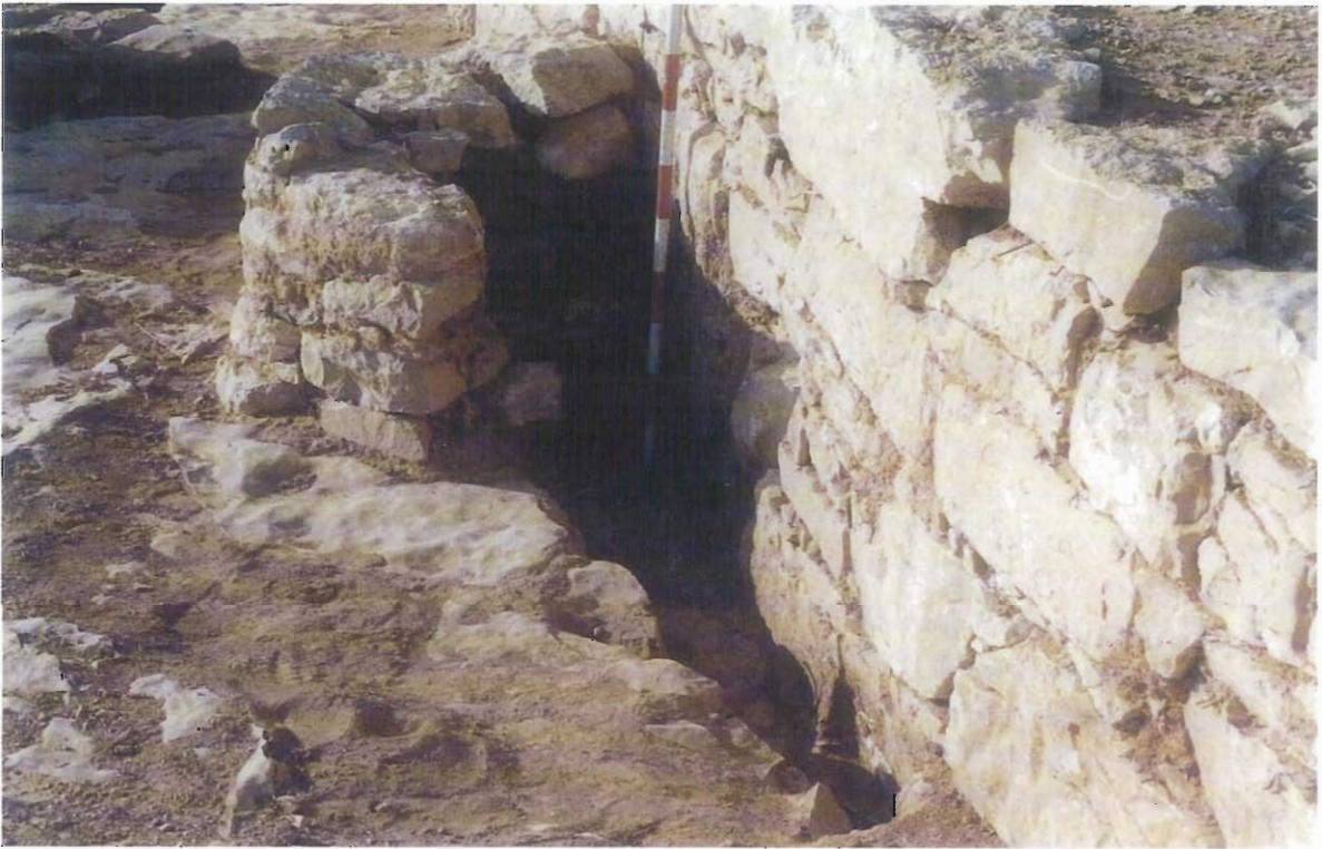
1. Estructura arquitectónica unidad estratigráfica 1016.
