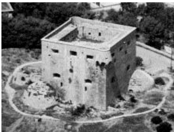
Foto 4.- La Torre vista des de l'est.
