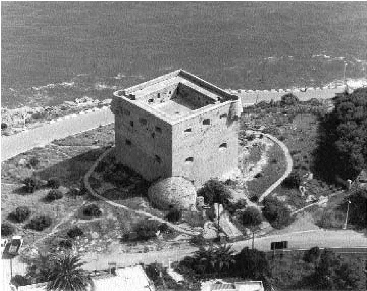
Foto 3. Estat actual de la Torre del Rei.
