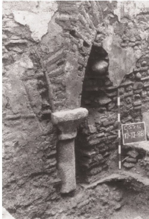
1. Detall de la secció estratigràfica amb els pisos successius i cimentació del pilar.
