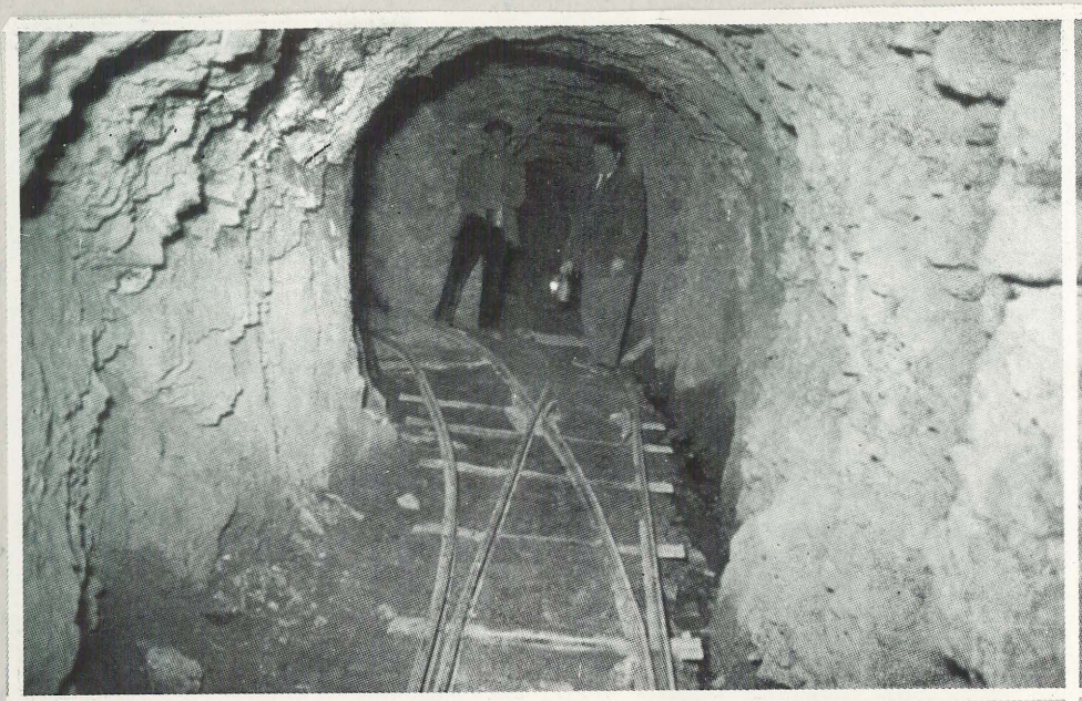
Fig. 18.—Galerías en pizarras que contienen un sistema de filones de casiteritas, de rumbo NE. El Trasquilón. Cáceres.
