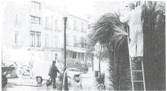
Membres de la Brigada d'Obres reparant el portal Gica S.
