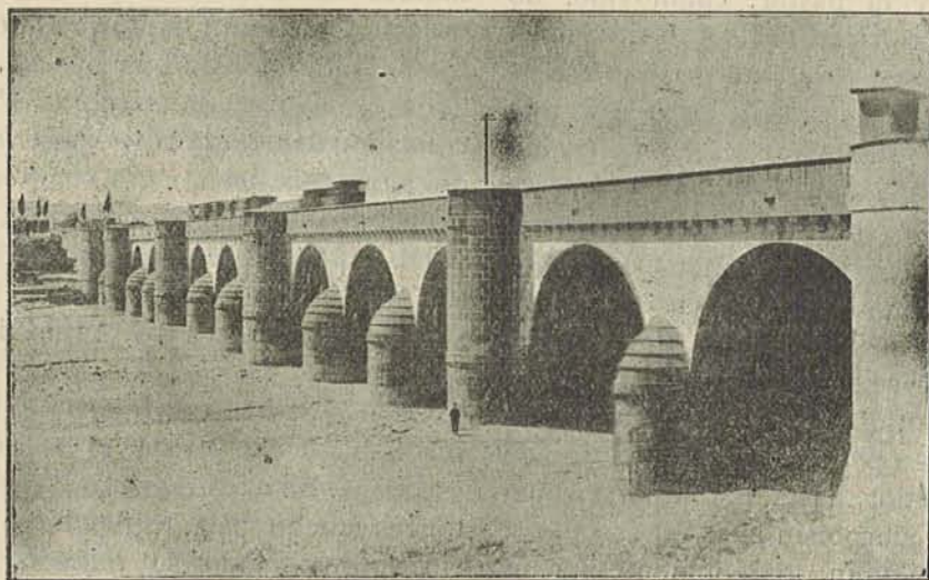
VILLARREAL.—Puente sobre el Río Mijares
