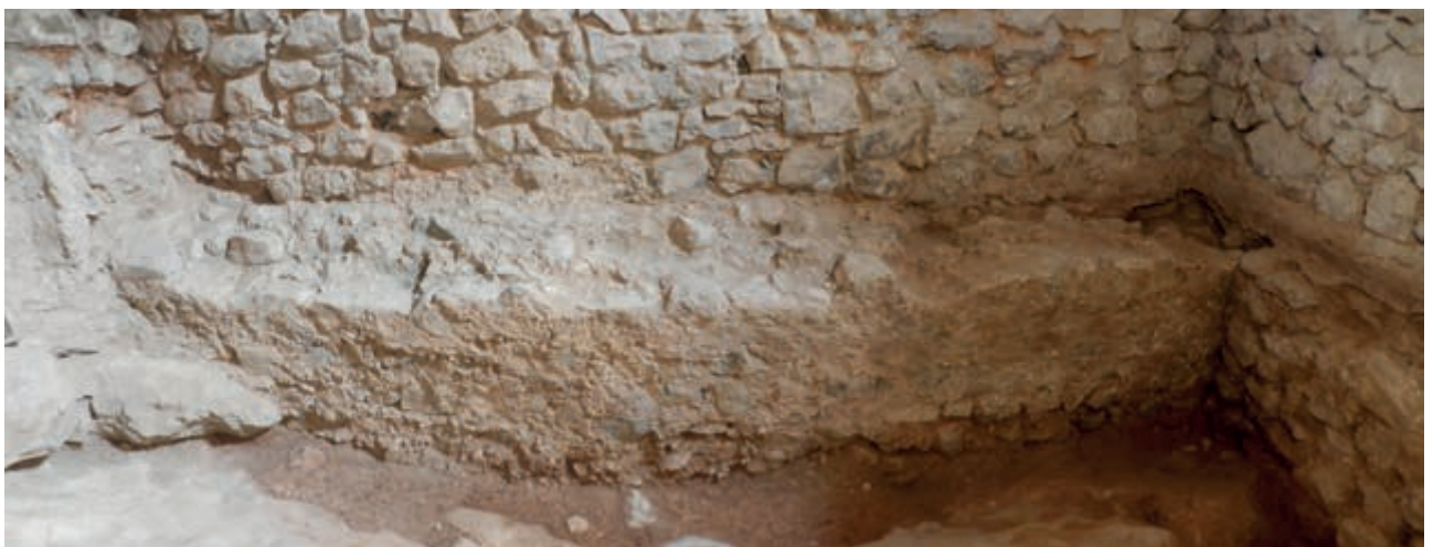
Figura 15. Les restes de la muralla del segle XVII a la part baixa del mur nord.
