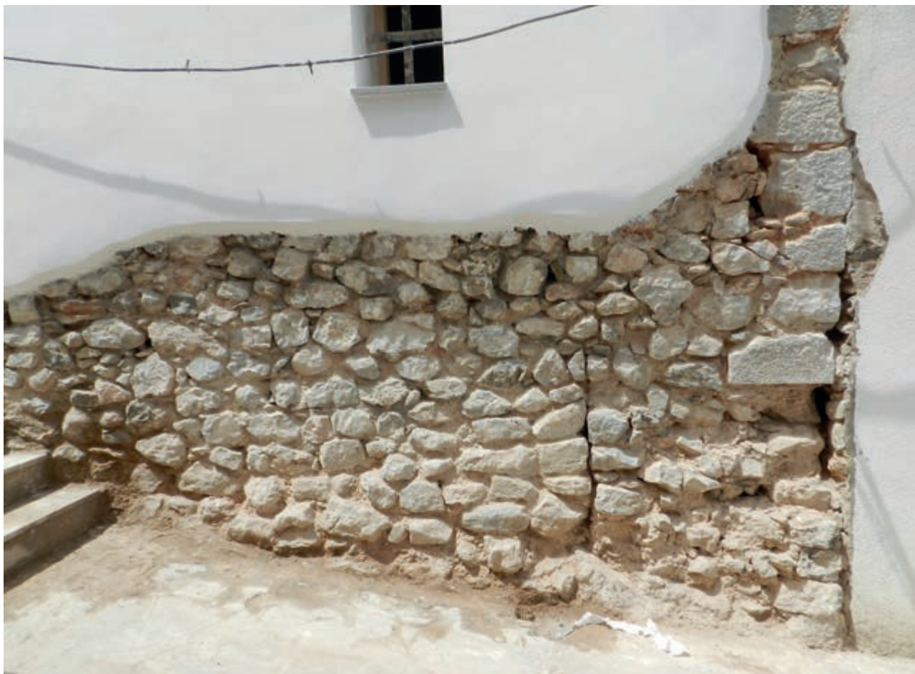
Figura 18. Detall de la finestra arqueològica en la façana exterior.
