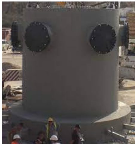
Ilustración 17: Ejemplo torre de captación de hormigón
