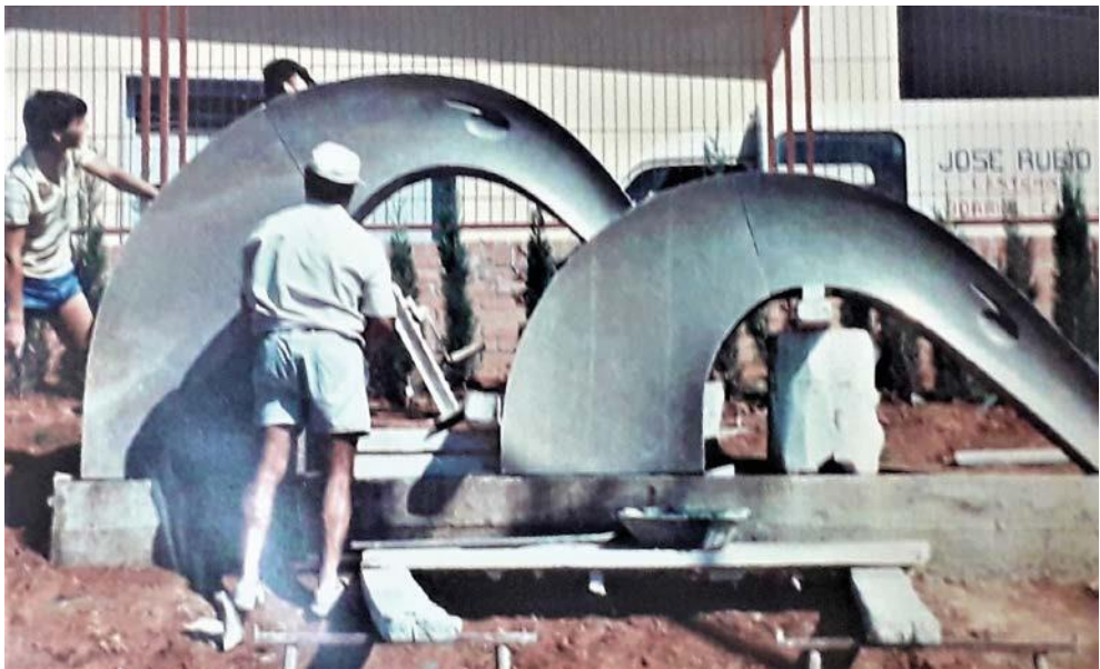
Muntant les peces de pedra amb carranquí. (6)
