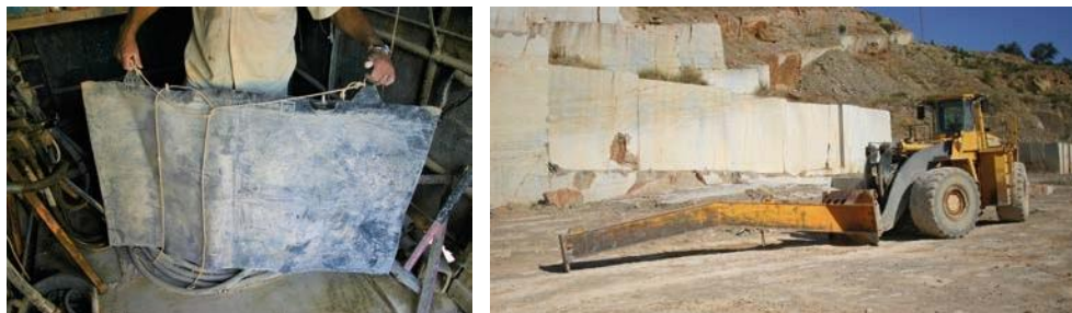
Bossa neumàtica i excavadora amb l'ungla, a la Pedrera de l'Abeller (Canteras Bernad S.L.)
