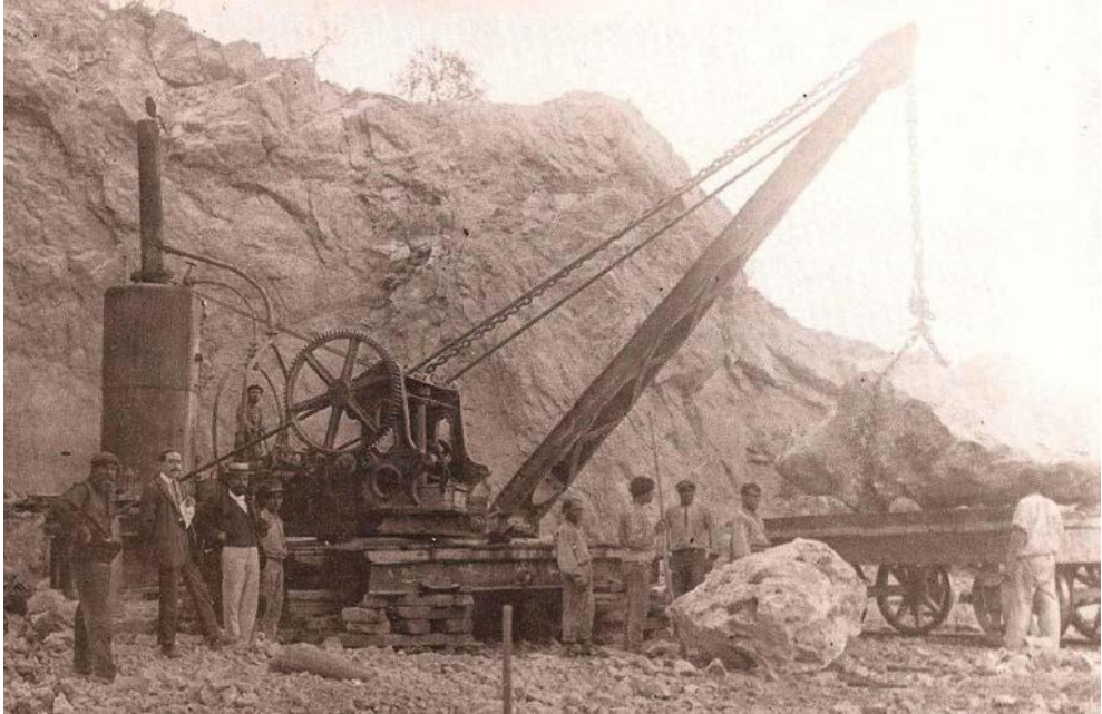
Grua a la Pedrera del Moll de Castelló.
