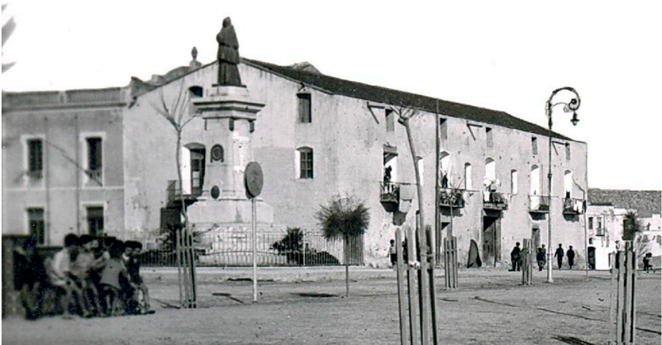
Figura 5. Vista desde el sur del edificio original de 1852, conocido como Cotxera de Batet, que coincide con el perímetro del reducto del Fortí y un ámbito anexo (Colección A. Gómez, primera mitad del siglo XX).
