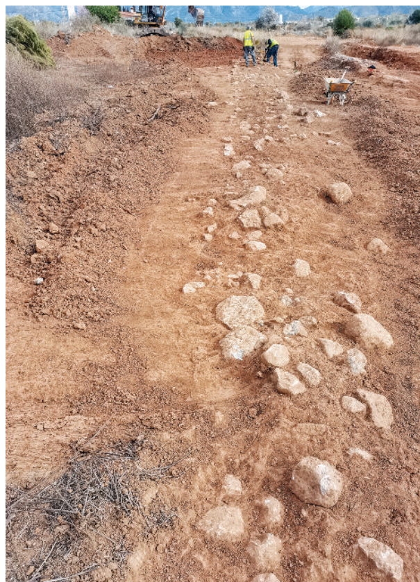
Figura 8. Treballs de neteja i excavació del tram del camí que segueix cap al sud-oest en març de 2022.
