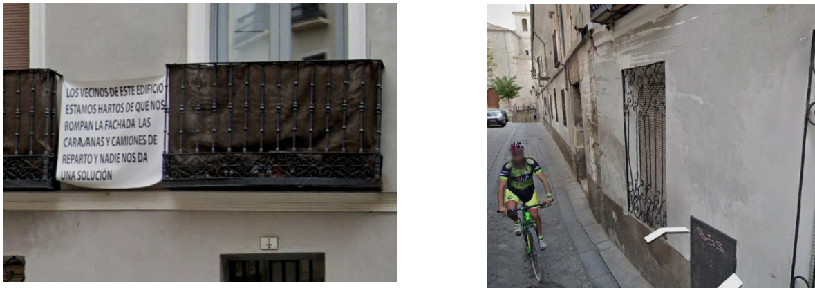
Figura 4.16. Fachadas rotas por camiones en Cuenca. Fuente Google Earth.
