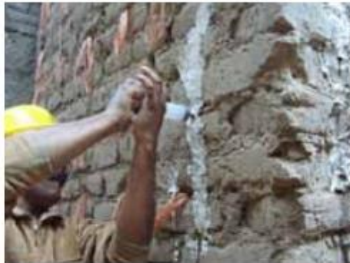
Figura 5.5 Inyección de lechada en fisuras. Fuente (Peñaranda, 2011)
