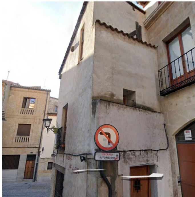
Figura 4.27. Sustitución de marco y ventana. Fuente: Google earth.
