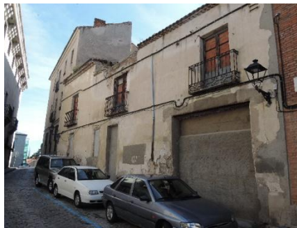
Figura 4.4. Casas abandonadas Ávila. Fuente Google Earth.
