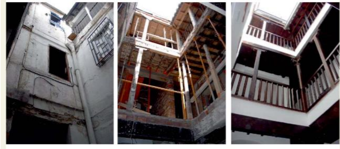
Figura 2.3. Rehabilitación de un edificio del Albaicín (Granada). Fuente (Empresa Pública de Suelo de Andalucía, 2021)
