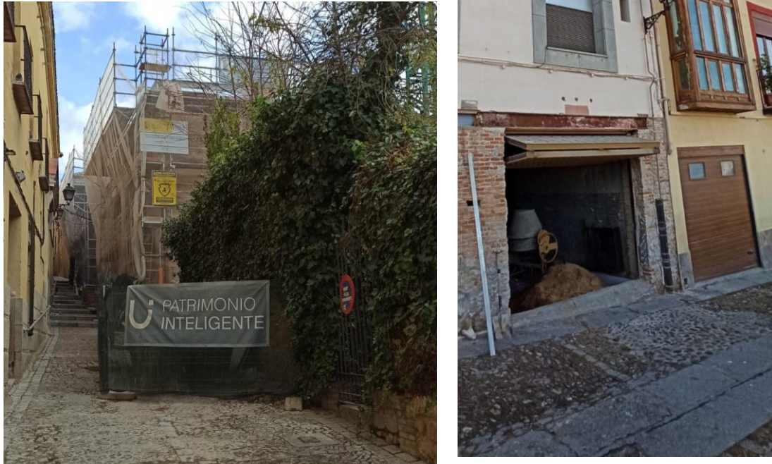
Figura 4.22. Viviendas en proceso de rehabilitación en Toledo. Fuente propia.
