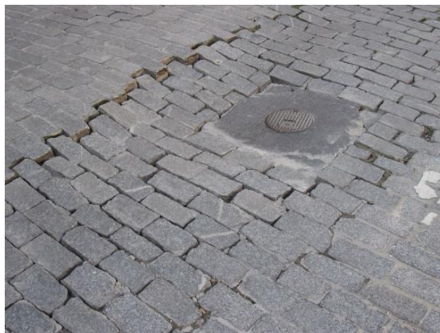
Figura 4.11. Hundimientos en calles de Salamanca. Fuente “Ciudadanos por la Defensa del Patrimonio”
