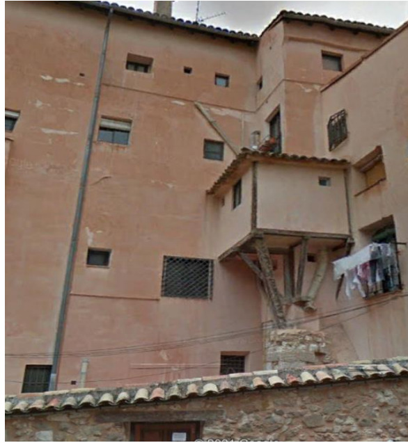
Figura 4.28. Baño en ampliación. Fuente: Google earth.
