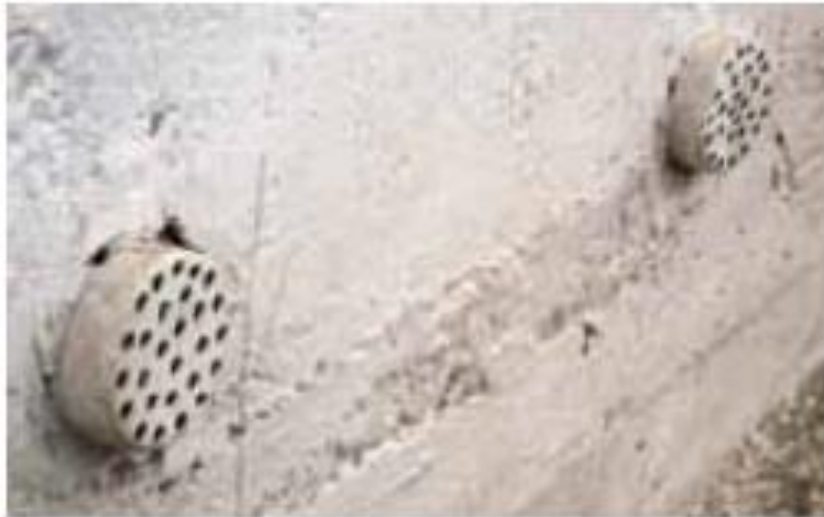
Figura 5.7. Sifones en cimentación. Fuente (Peñaranda, 2011)
