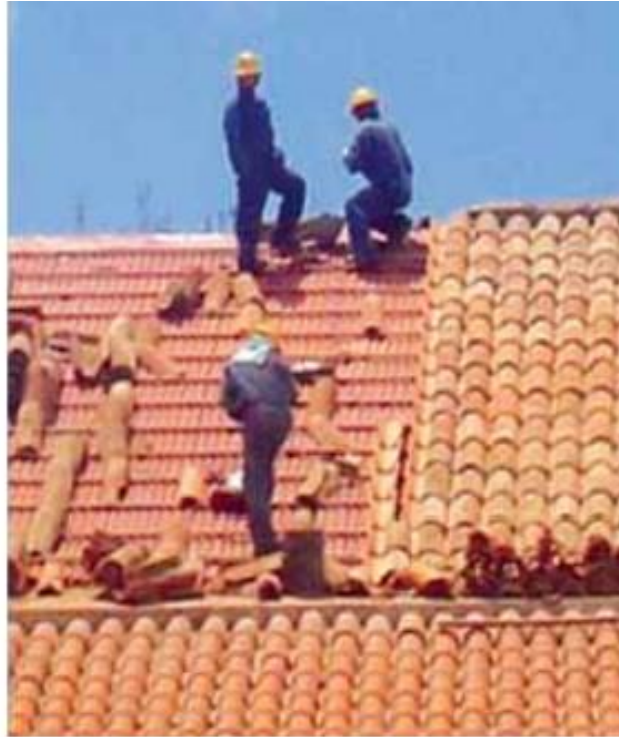
Figura 5.1 Sustitución con recuperación de tejas originales. Fuente (Peñaranda, 2011)
