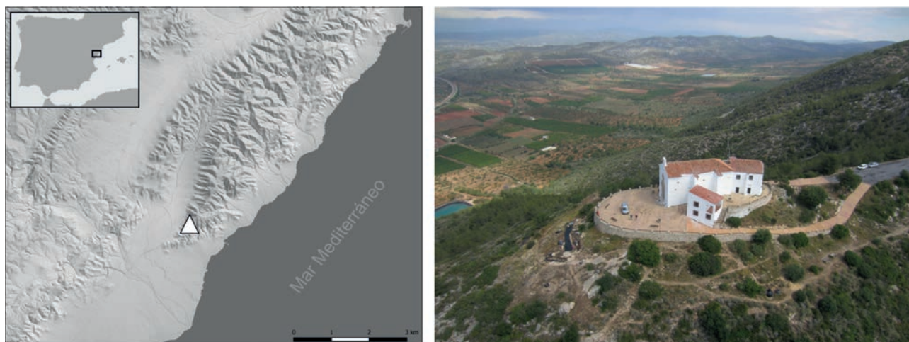
Figura 1. Situación de Santa Llúcia y vista aérea desde el sudeste.
