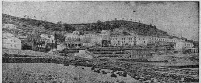
VISTA GENERAL DEL BALNEARIO
