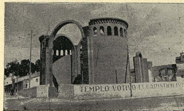
Estado actual de las obras del Templo Votivo de San Pascual Bailón
