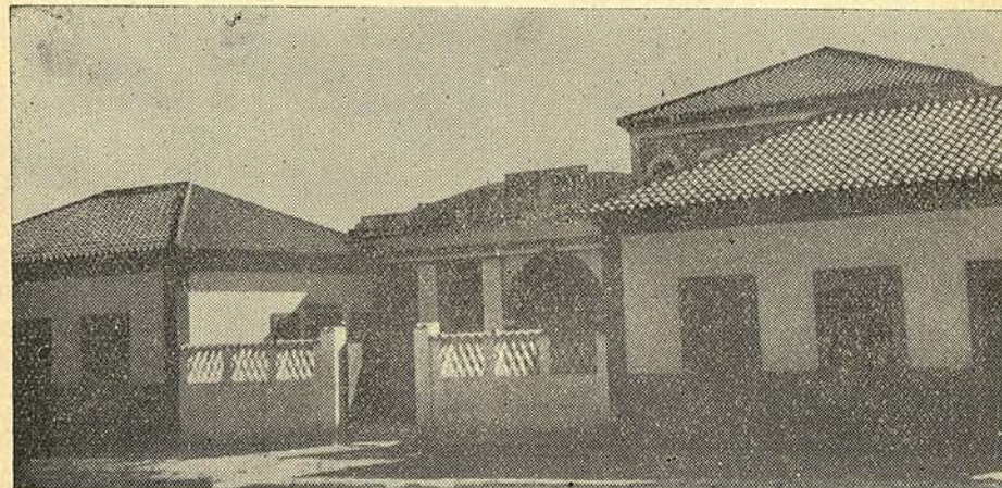
Nuevo Matadero Municipal
