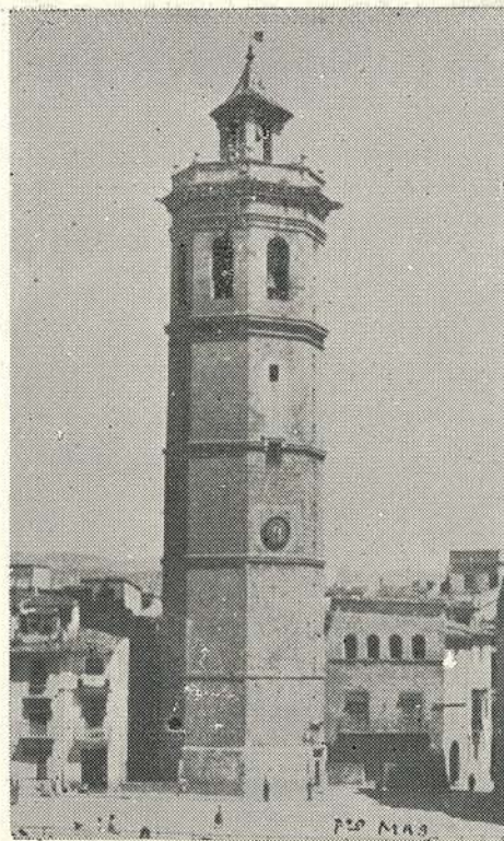
CAMPANARIO, prisma octogonal, separado en cinco cuerpos por impostas corridas y terminado con un templete. Construcción del siglo XVI
