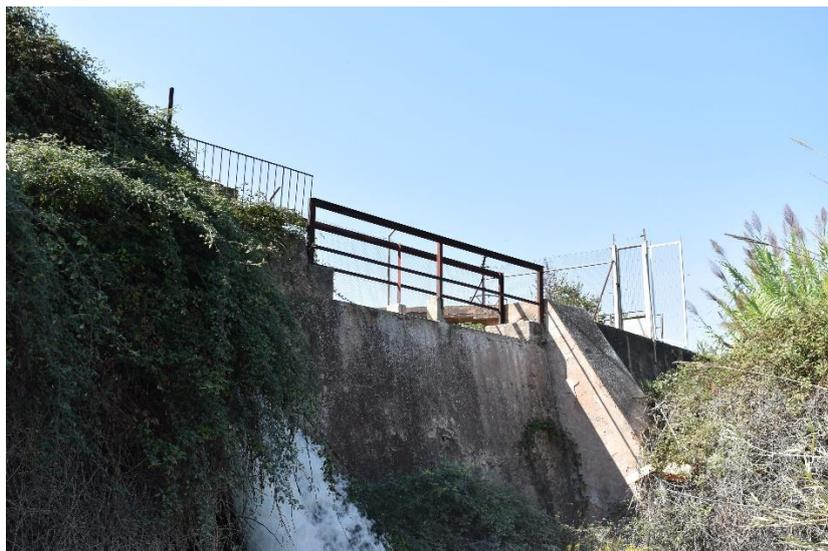
**Ilustración 5. Aliviadero desde la parte de abajo de la central, junto con la compuerta de descarga (por donde fluye el cauce de la acequia)**
