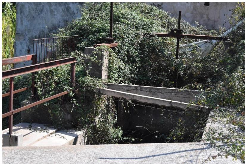
**Ilustración 4. Compuertas utilizadas para controlar la entrada o retención del caudal de la Acequia Mayor de Sagunto.**
