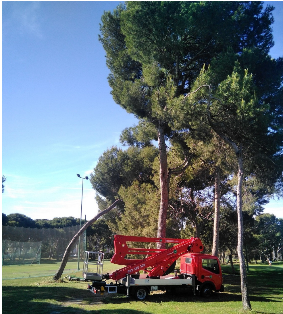
Anexo 3. Imagen 14. Fotografía del campo de golf Costa de Azahar: Trabajos de mantenimiento en árboles
