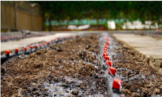
Ilustración 57 Botones insertados en tubería
