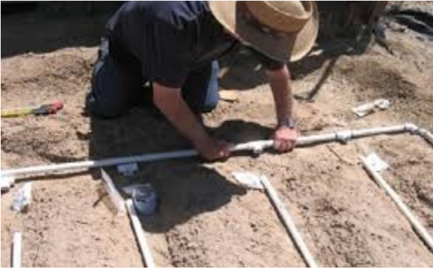
Ilustración 55 Conectando tuberías con conectores
