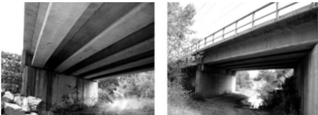
Figura 5. Instantáneas del puente Arroyo Bracea.
