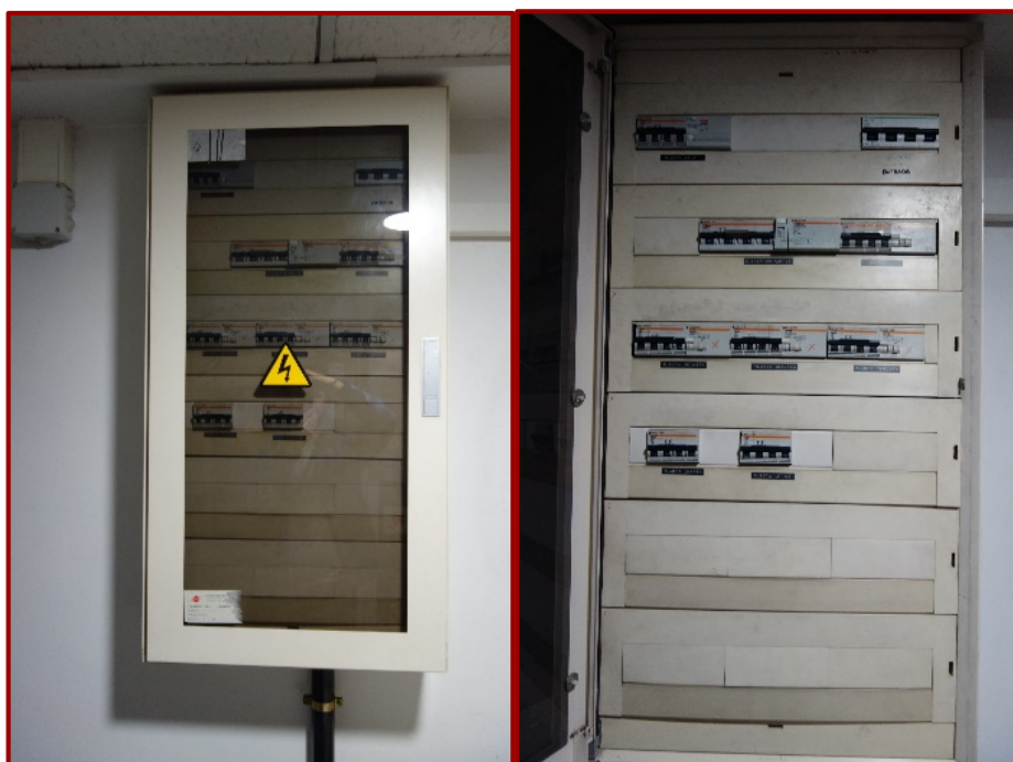
Imatge 14: Quadre general enllumenat per planta.
