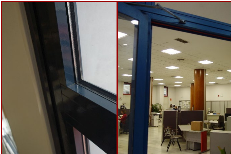
Imatge 5. Tancaments exteriors.
