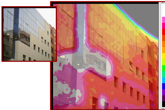
Termografia 13: Façana nord-est.
