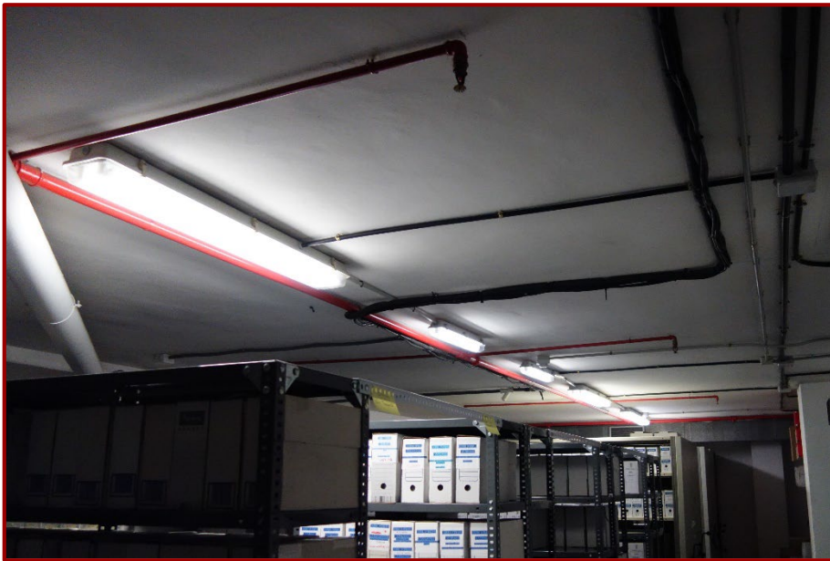
Imatge 18: Planta Sotterrani: Pantalla estanca de tubs LED Prolux.
