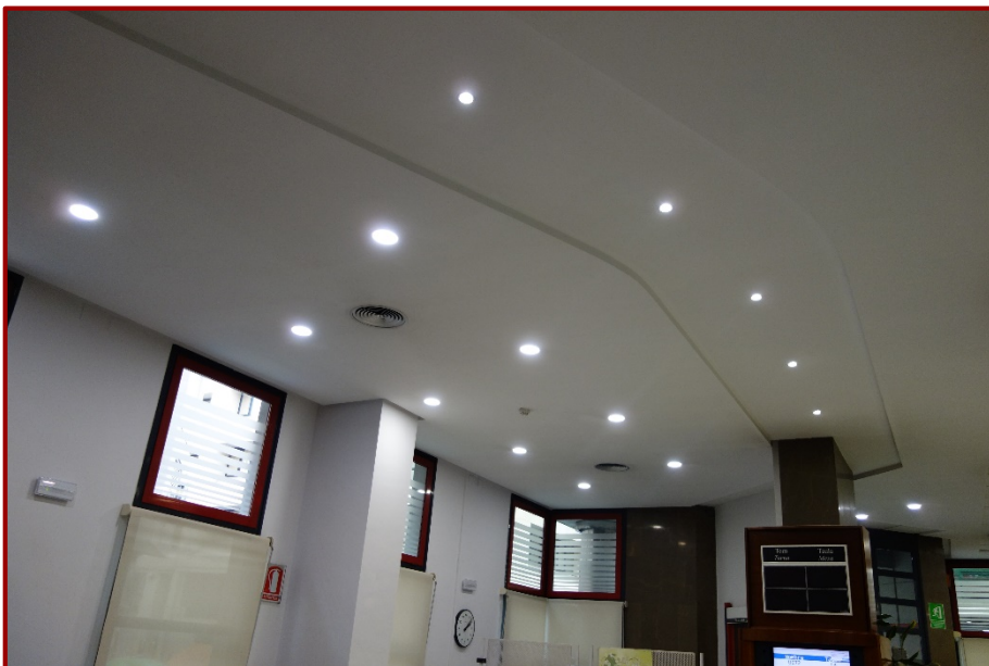
Imatge 19: Planta Baixa: DownLED Threeline DL16WN/ Porta llum Threeline LED GU10 7W.
