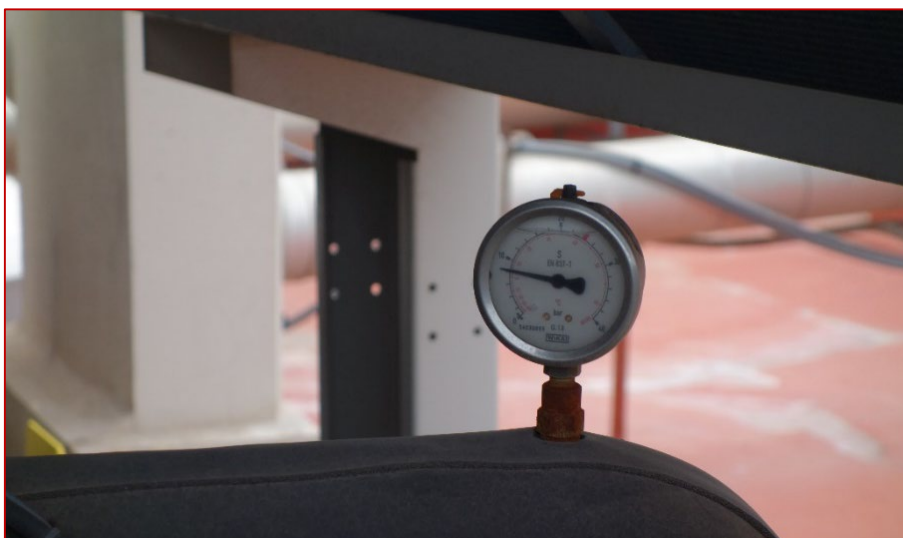
Imatge 42. Circuit de baixa pressió línia de líquid. Refredadora 8 bar.
