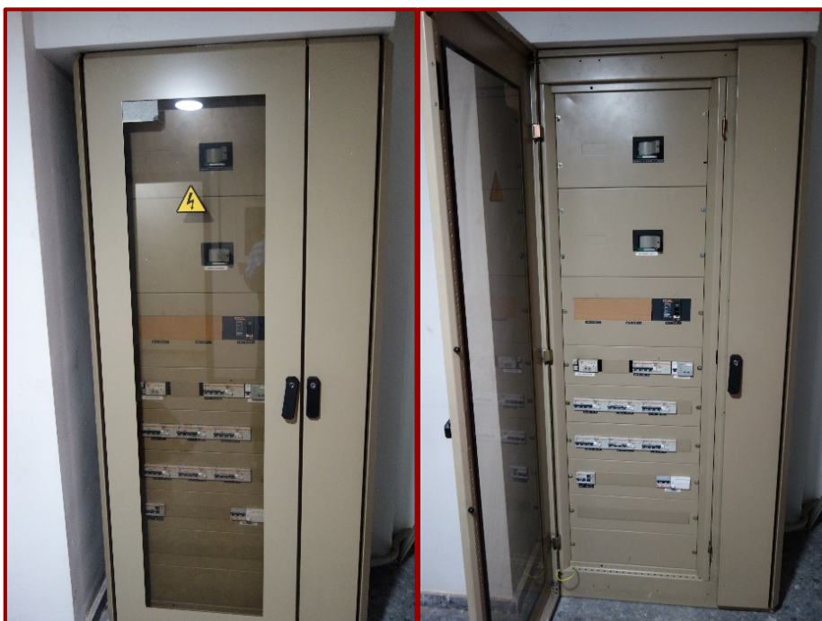
Imatge 13: Quadre equips de climatització.
