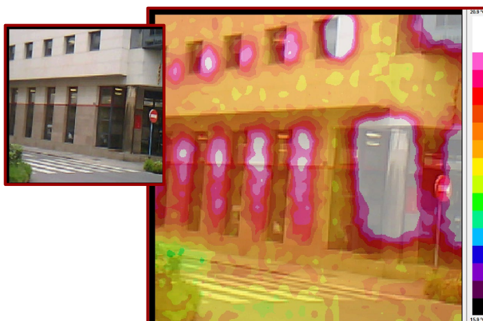
Termografia 11: Façana sud-est. Planta baixa.
