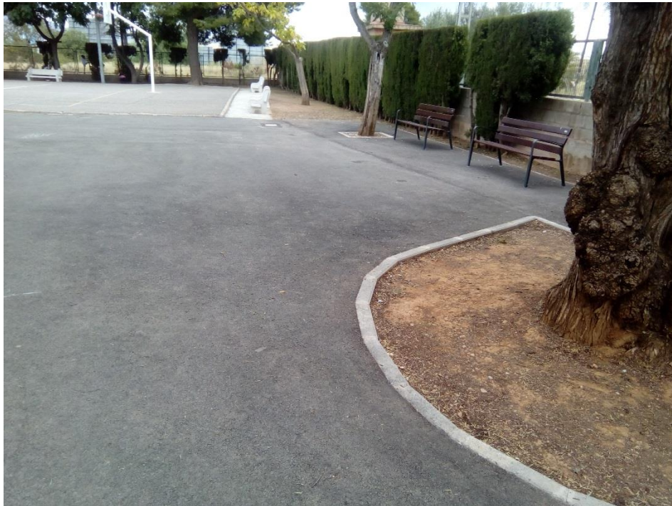
IMAGEN 3. Detalle del pavimento exterior.
