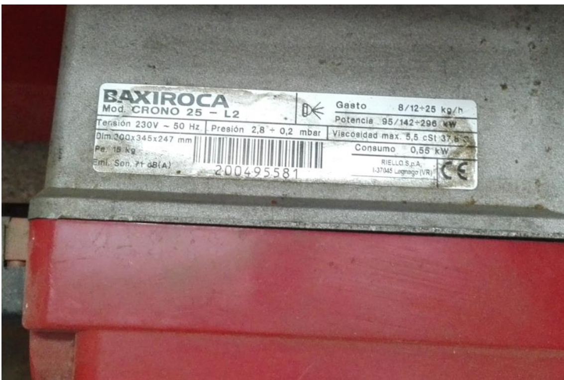
IMAGEN 9. Características del quemador.
